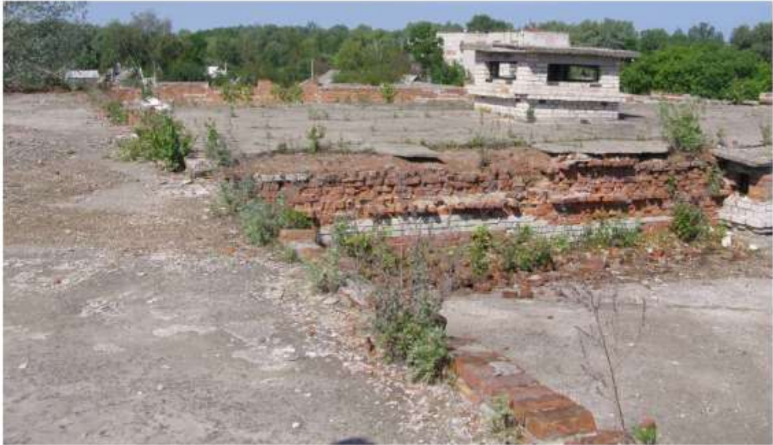
Рисунок 1.7 - Загальний вигляд покрівлі в осях А-Е
