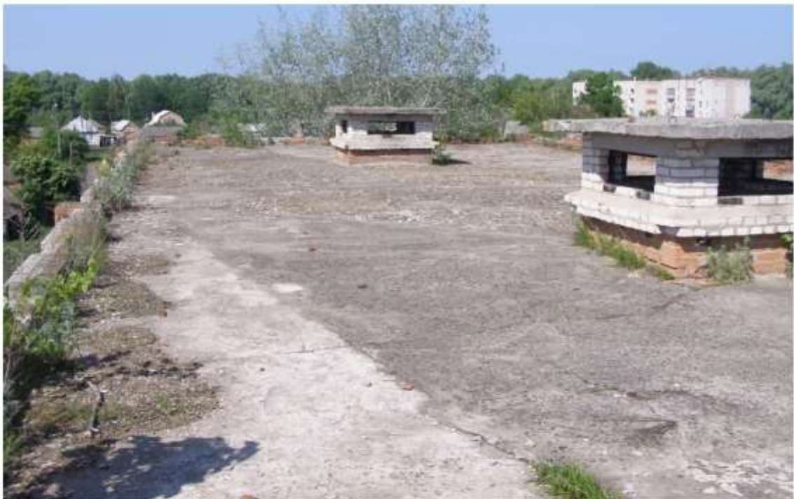
Рисунок 1.6 - Загальний вигляд покрівлі в осях Е-Ж
