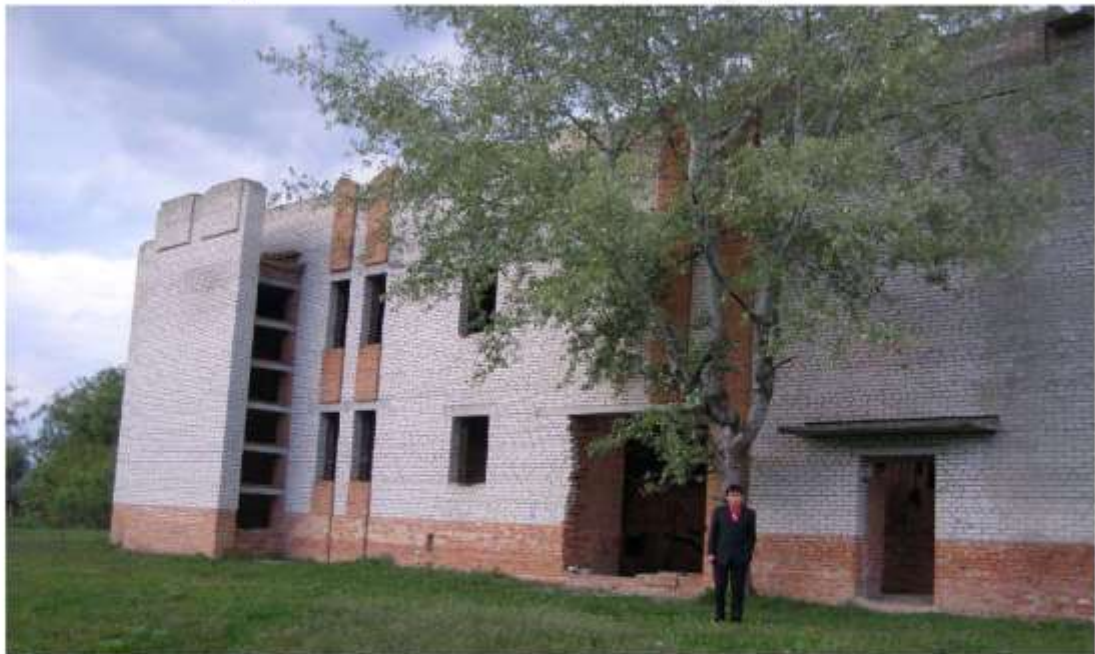
Рисунок 1.2 - Загальний вигляд фасаду будівлі по осі 10
