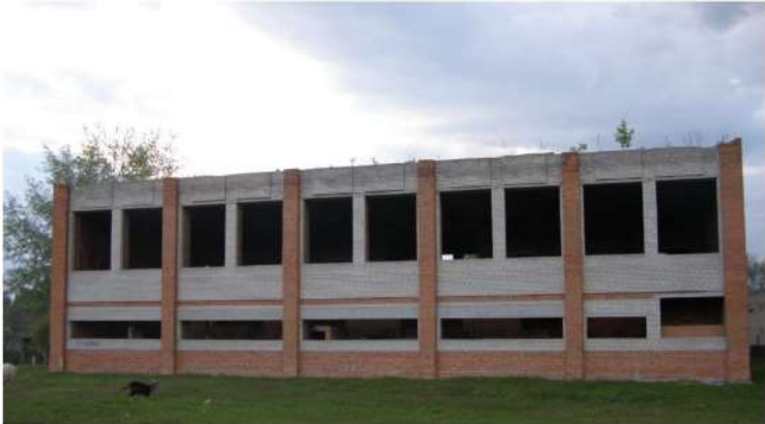
Рисунок 1.1 – Загальний вигляд фасаду будівлі по осі Ж
