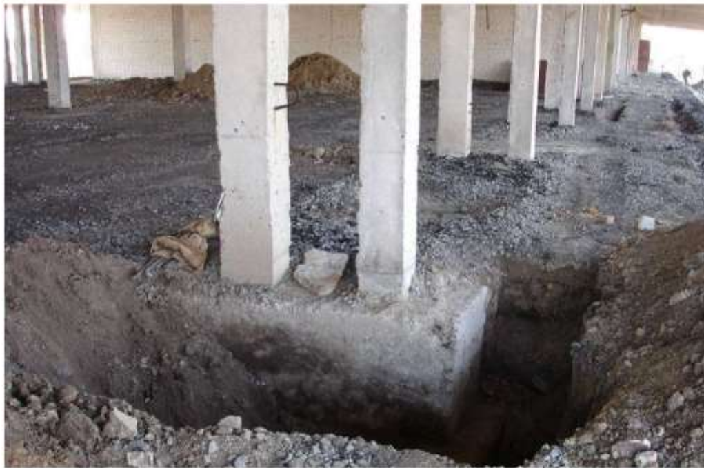
Рисунок 3.1 - Загальний вигляд шурфу 1
