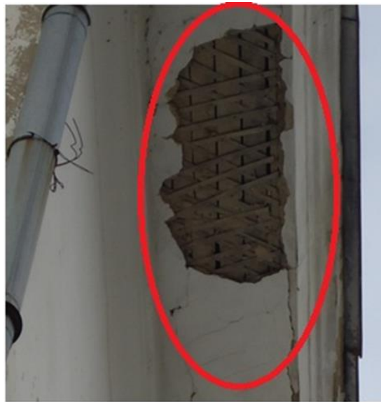
Рис.2. Руйнування карнизів
