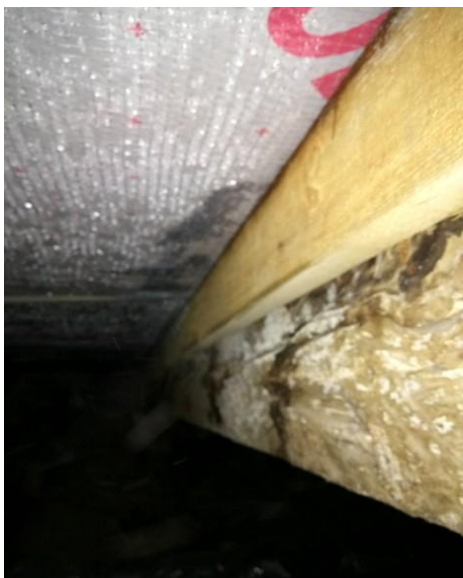
Рис.3. Конденсування вологи на внутрішніх поверхнях горища
