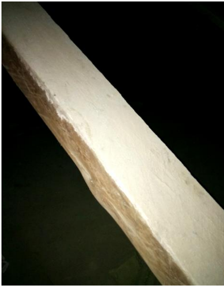
Рис.1. Біла пліснява на кроквах та укосах
