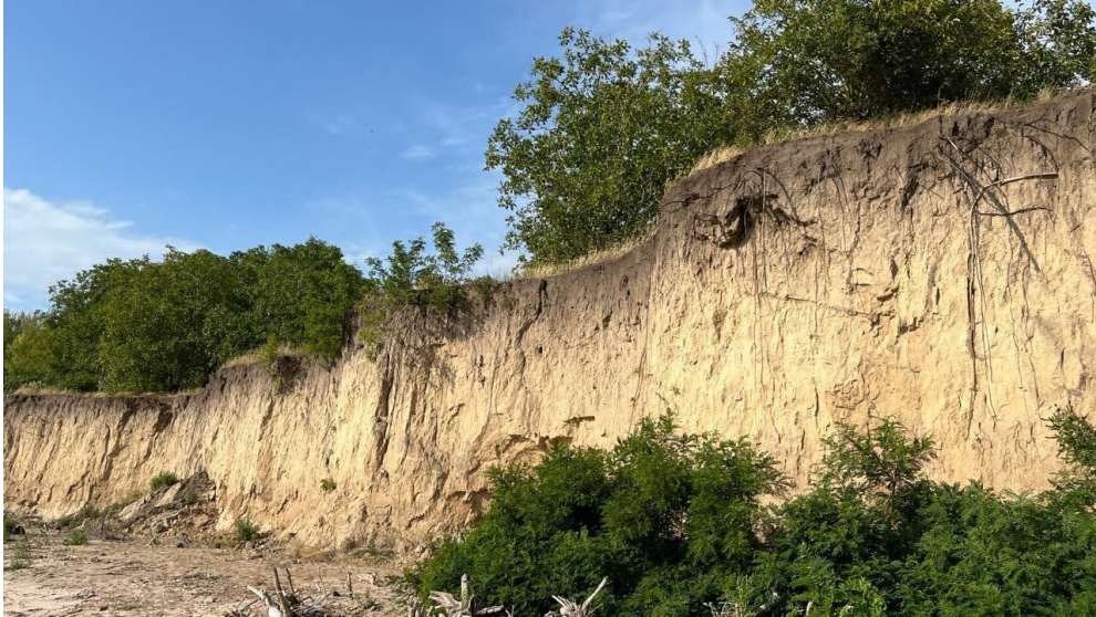
Рис. 4.1.5. Руйнування берегів Кременчуцького водосховища
