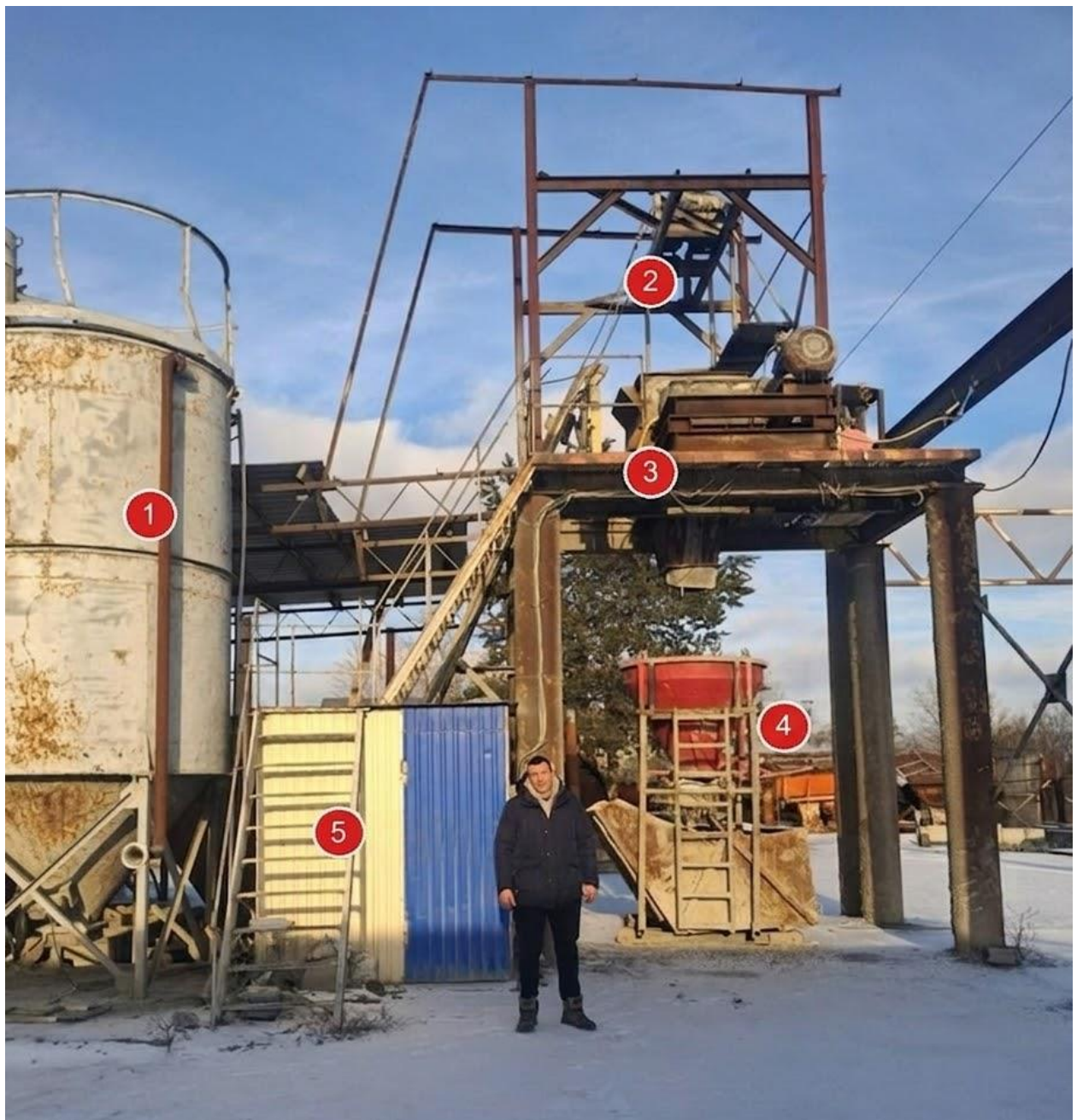
Рис. 3.6. Загальний вид бетонозмішувальної установки ТОВ «Асфер Груп» (продуктивність 60 м 3 /год): 1 – силос цементу V = 40 т; 2 - механізм підйому скіпа; 3 - змішувач примусової дії; 4 - бункер для прийому та розливки бетону по формах; 5 - пульт керування
