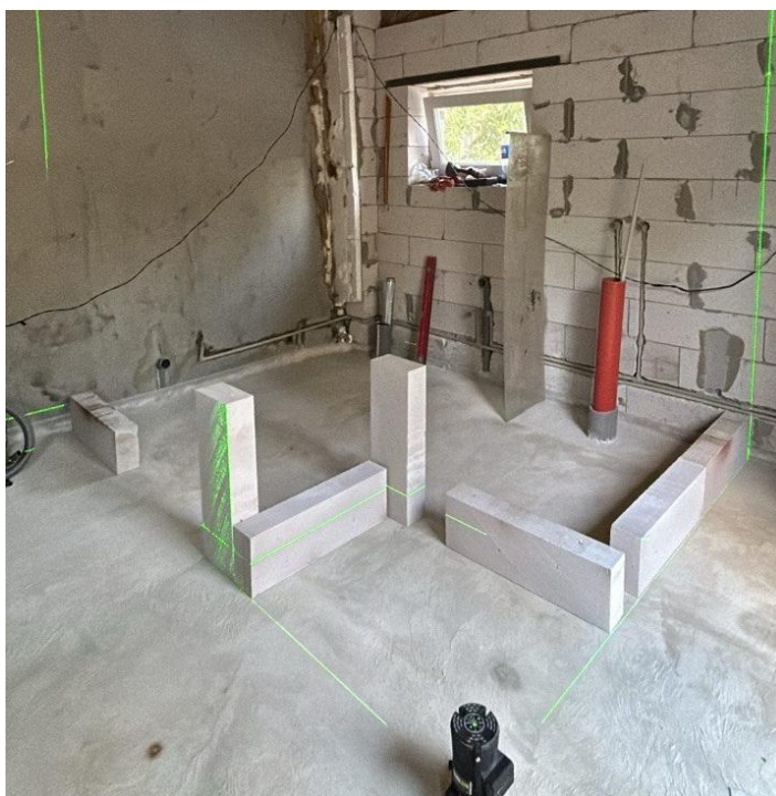
Рисунок 4.7 – Заливка підлоги фібробетоном
