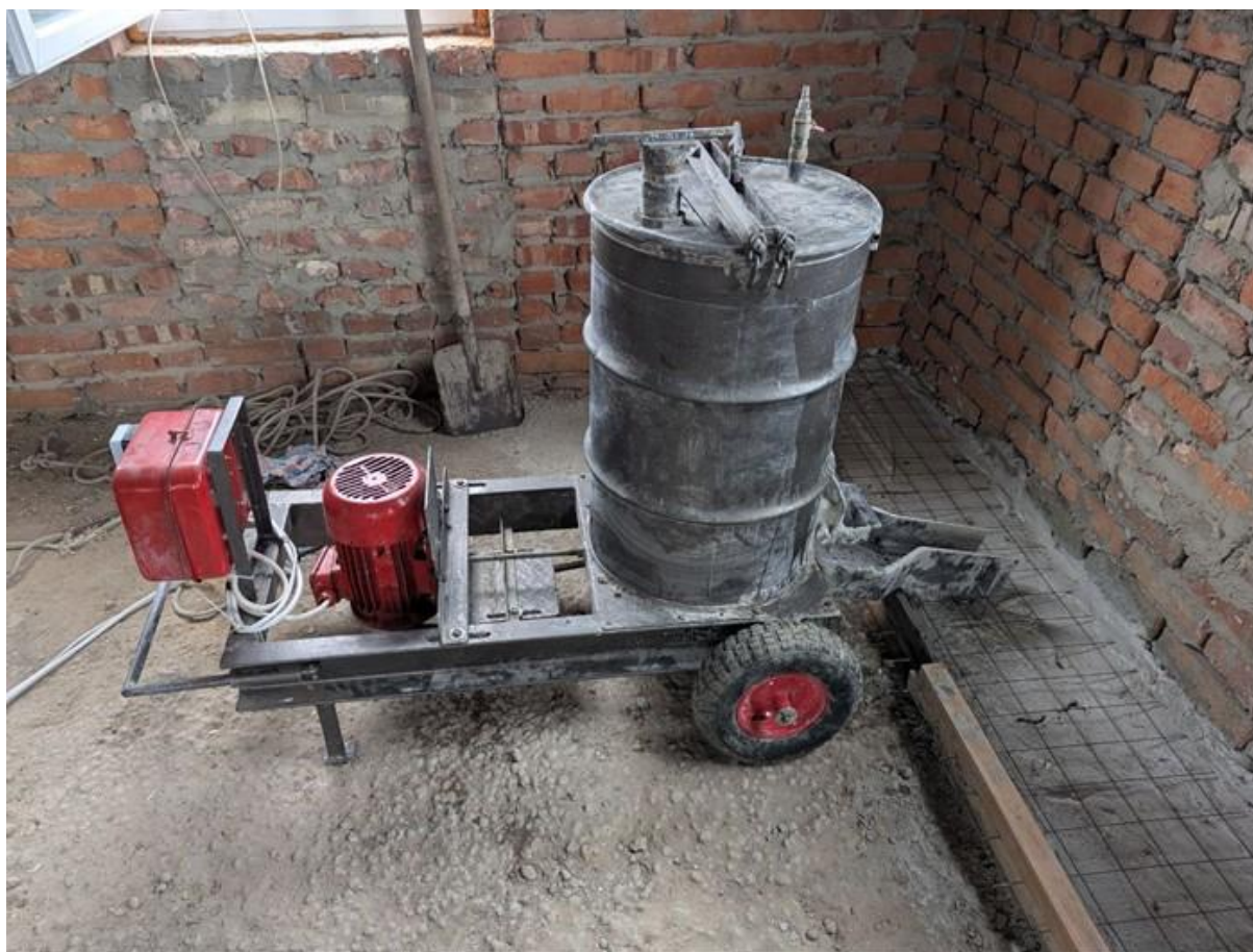
Рисунок 4.5. Установки для приготування ніздрюватих бетонів УдПНБ-100 в місці проведення бетонних робіт.
