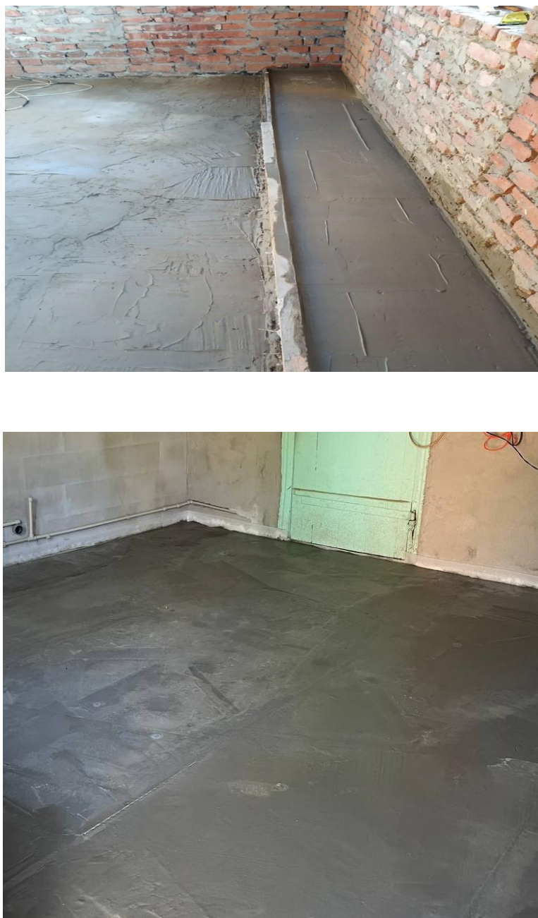
Рисунок 4.6 – Облаштування підлогового покриття з ніздрюватим методом заливки
