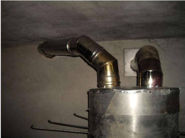
Рисунок 1 – Верхня частина печі з рекупераційним ковпаком та системою відводу підігрітого повітря
