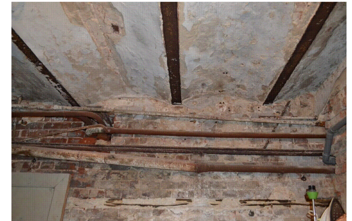
Загальний вигляд перекриття над підвалом
