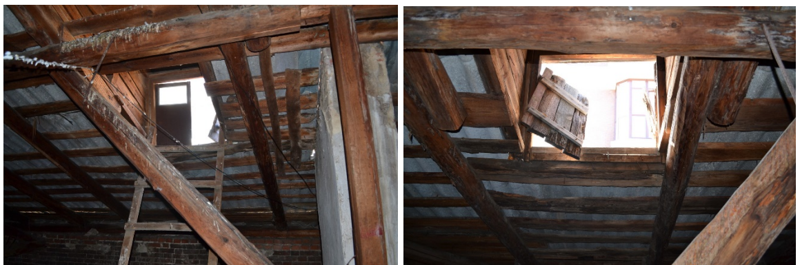
Рис. 2.11 – Загальний вигляд слухових вікон.
