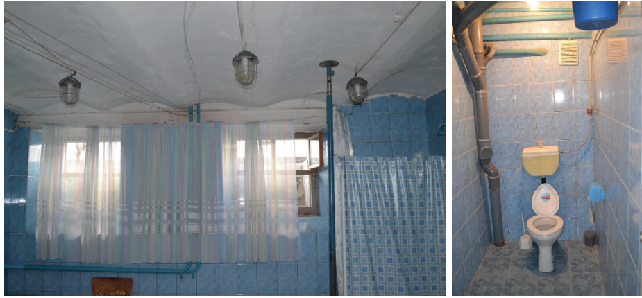
Рис. 2.4 – Загальний вигляд підвальных приміщень будівлі (в осях В-К; 5-7)
