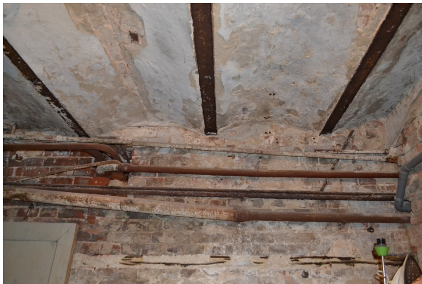
Рис. 2.9 – Загальний вигляд перекриття над підвалом.
