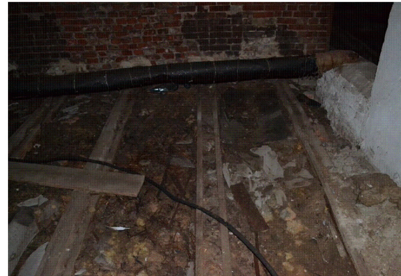
Загальний вигляд перекриття по дерев'яних балках
