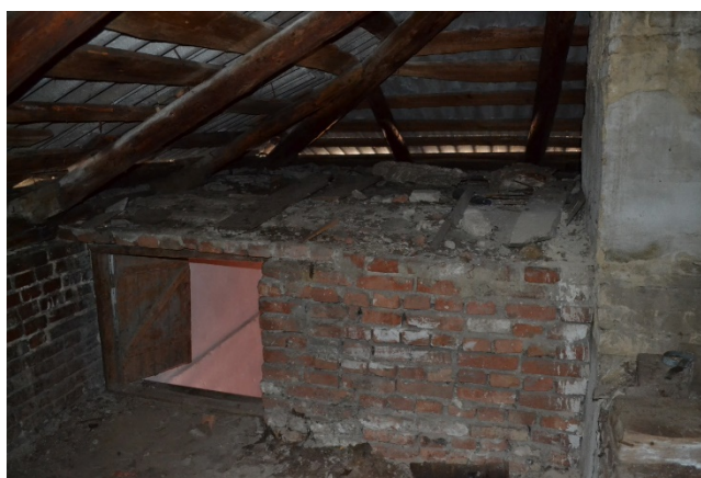
Рис. 2.7 – Загальний вигляд приміщень 1-го поверху будівлі.
