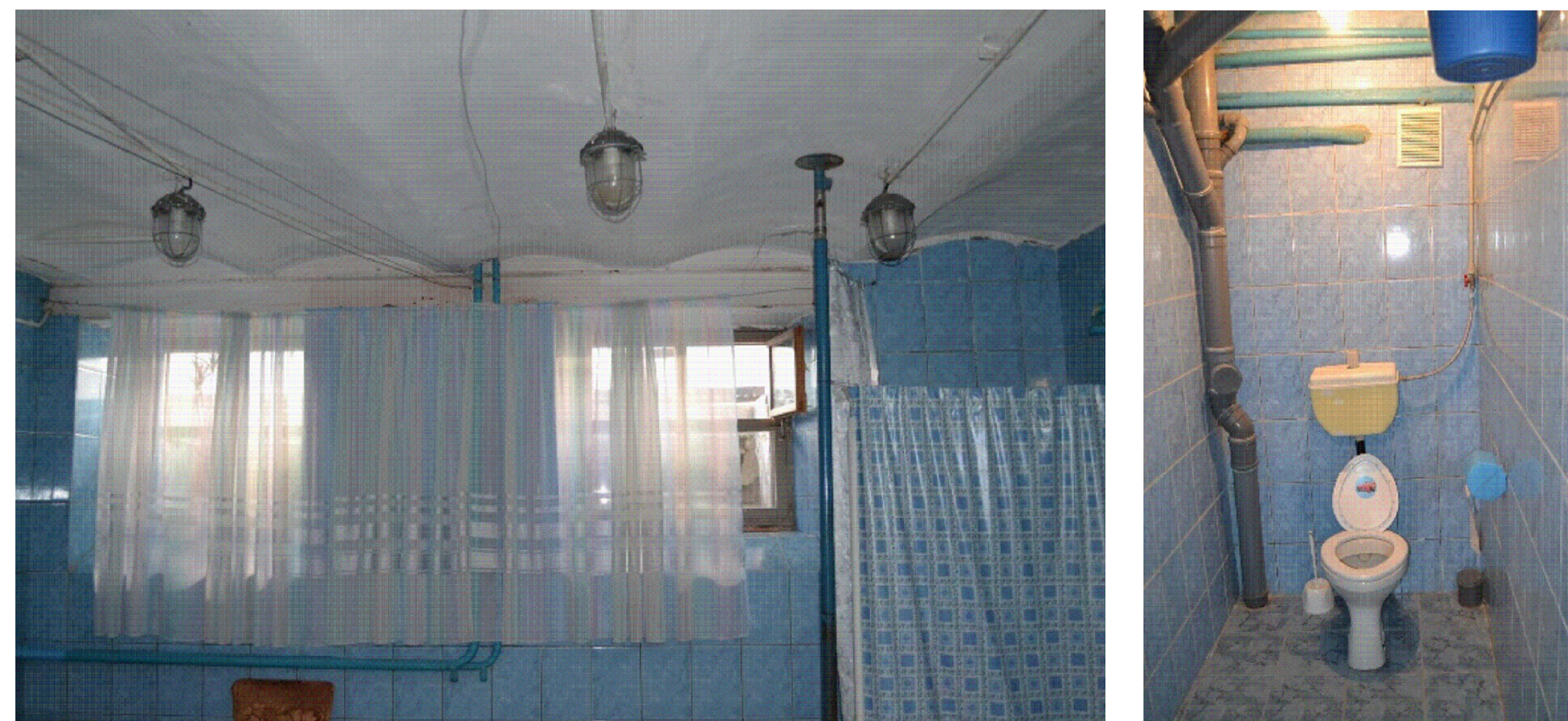
Загальний вигляд підвальних приміщень будівлі (в осях В-К; 5-7)
