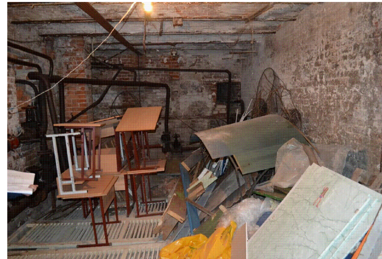
Загальний вигляд підвальних приміщень будівлі (в осях В-Д; 4-6)
