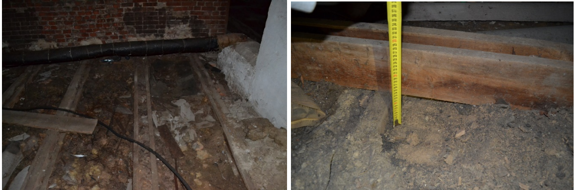
Рис. 2.8 – Загальний вигляд перекриття по дерев'яних балках.
