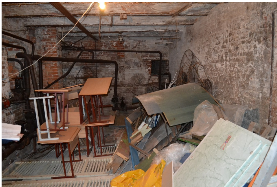
Рис. 2.5 – Загальний вигляд підвальных приміщень будівлі (в осях В-Д; 4-6)
