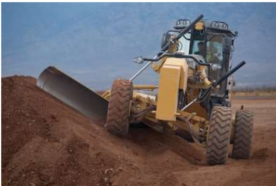
Рисунок 1.3 – Робота автогрейдера під час переміщення та профілювання ґрунтового матеріалу
