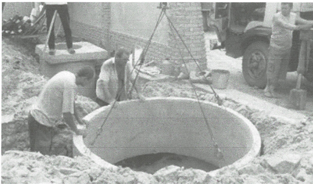
Рисунок 1.6 – Установлення залізобетонного кільця у підготовлений котлован
