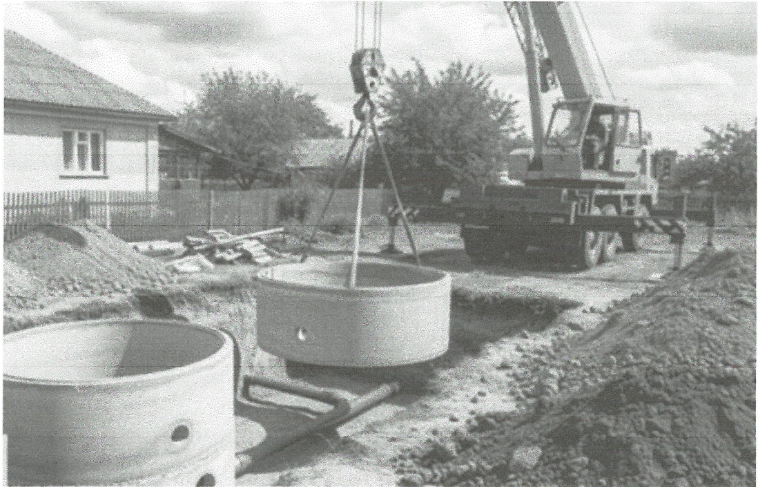
Рисунок 1.5 – Монтаж залізобетонного кільця за допомогою автокрана
