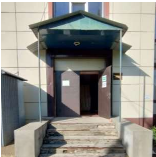
Рисунок 2.2 – Центральний вхід до приміщення Краснокутської публічної бібліотеки. Світлина зроблена автором
