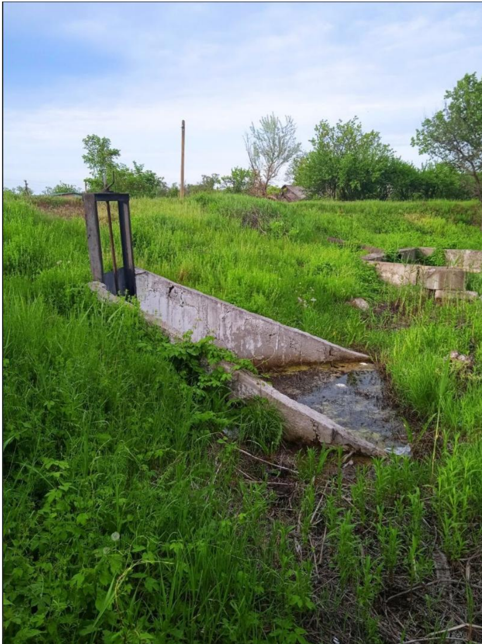
Рис. Е.1. Аварійний (неробочий) стан шлюзу-регулятора в районі села Нехвороща, що унеможлиблює промивання русла.
