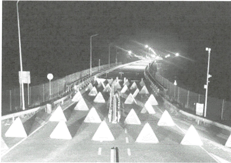
Рисунок 1.1 – Приклад використання загороджувальних пірамід для обмеження руху транспорту
