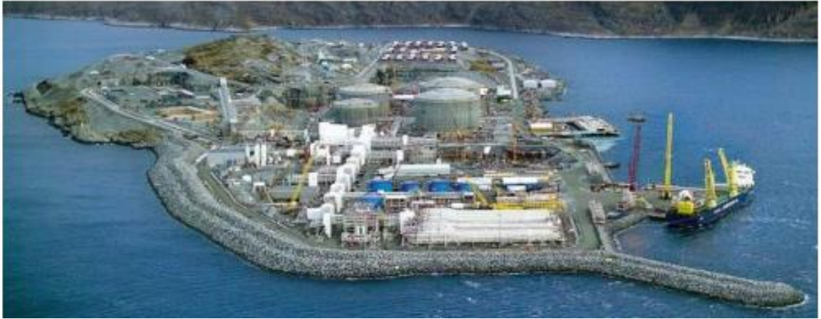
Рисунок 2.8 – Snohvit, LNG, будівництво майданчика в Норвегії [81].
