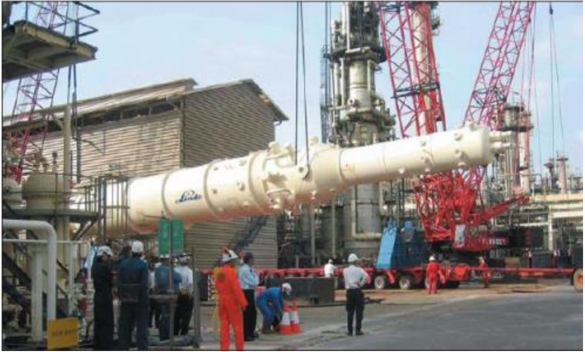
Рисунок 2.12: Підйом Linde MCHE на заводі BLNG [92]
