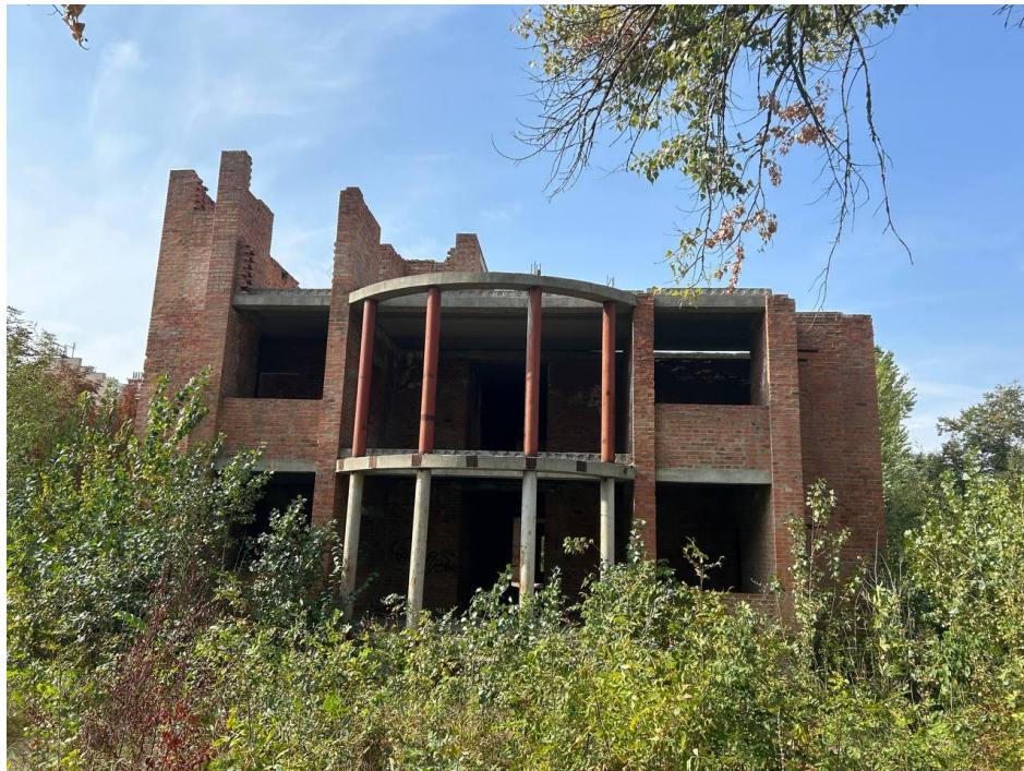
Рис. 2.4 – Загальний вигляд поздовжнього фасаду будівлі в осях А-П
