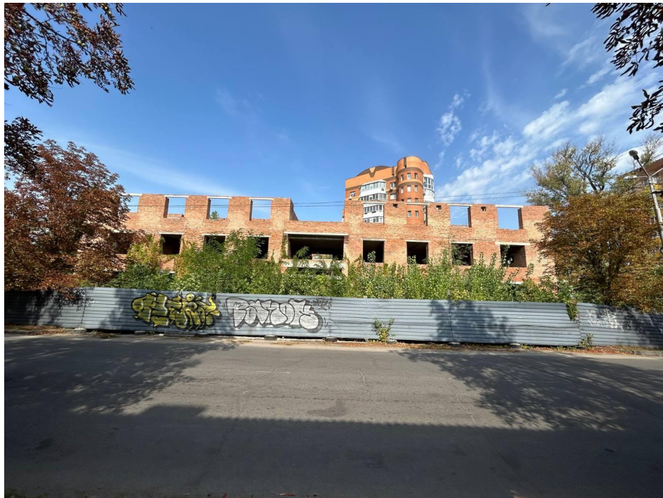
Рис. 2.2 – Фото загального вигляду поздовжнього фасаду будівлі в осях 1-11
