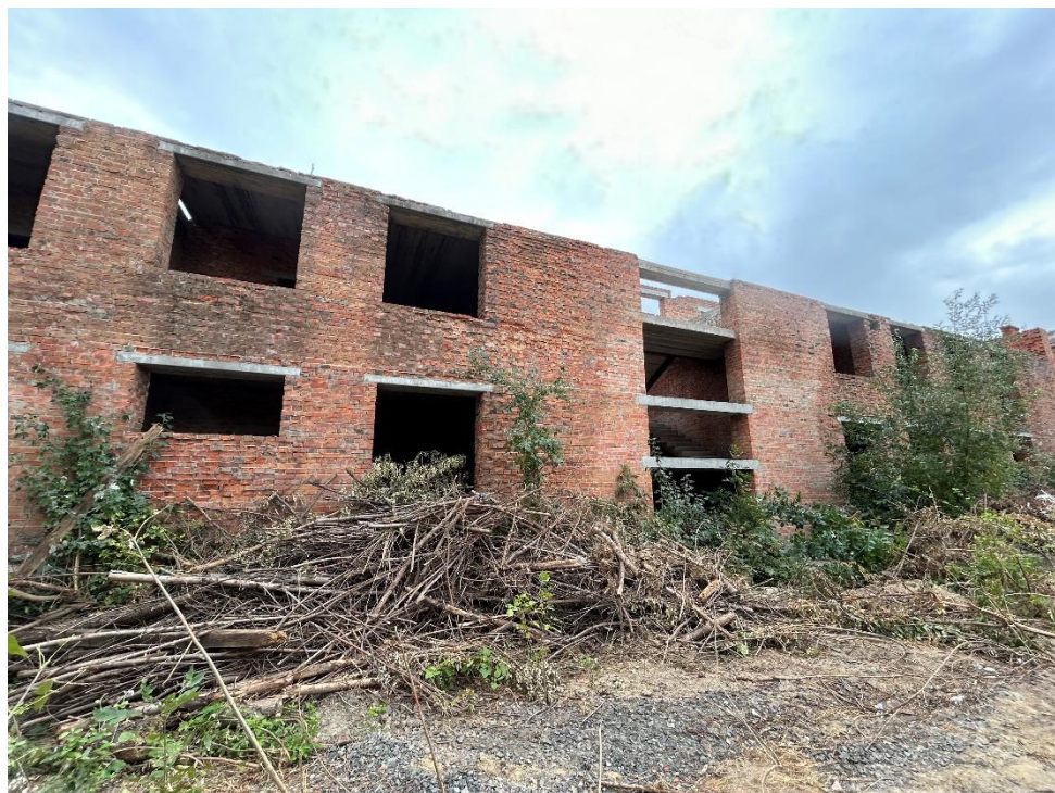
Рис. 2.3 – Фото загального вигляду поздовжнього фасаду будівлі в осях 11-1
