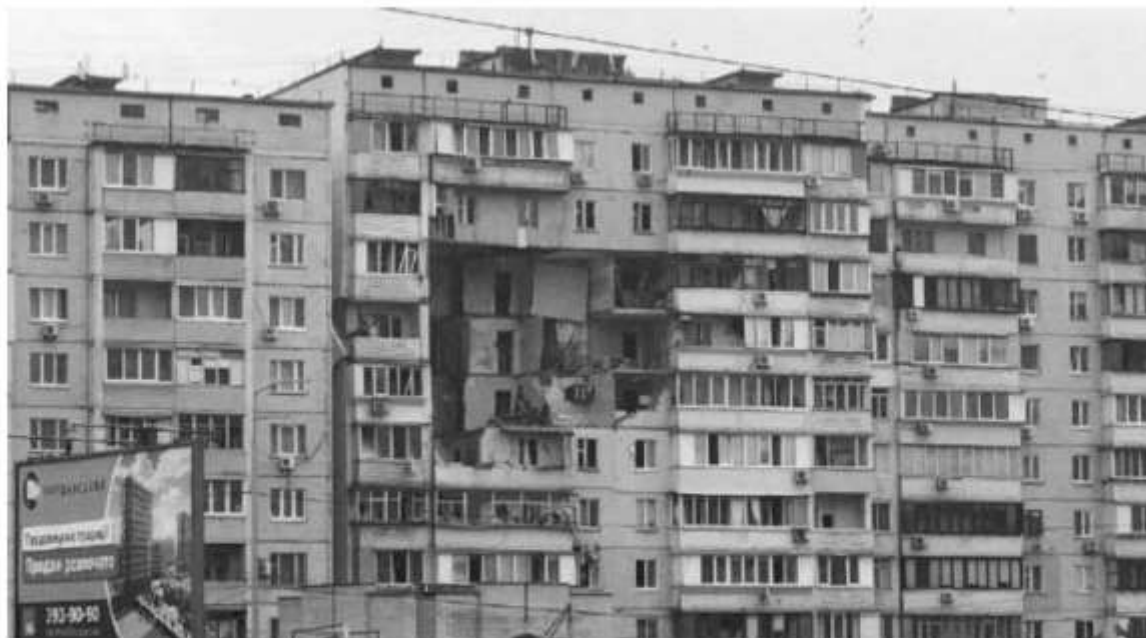
Рис. 9 Фасад будівлі, що підлягає частковому демонтажу
