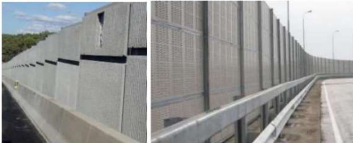
Рис. 5 Бетонний та металевий шумозахисний екран
