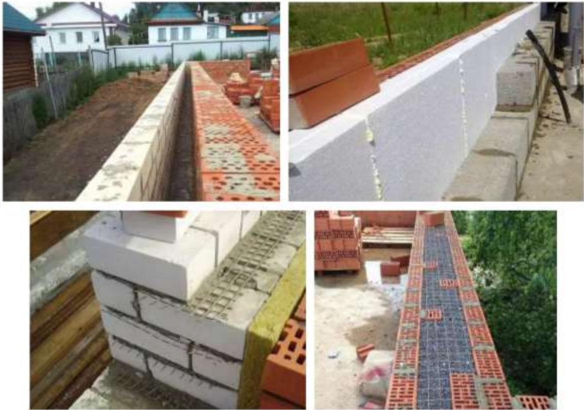
Рис. 2 – Варіанти колодязної кладки
