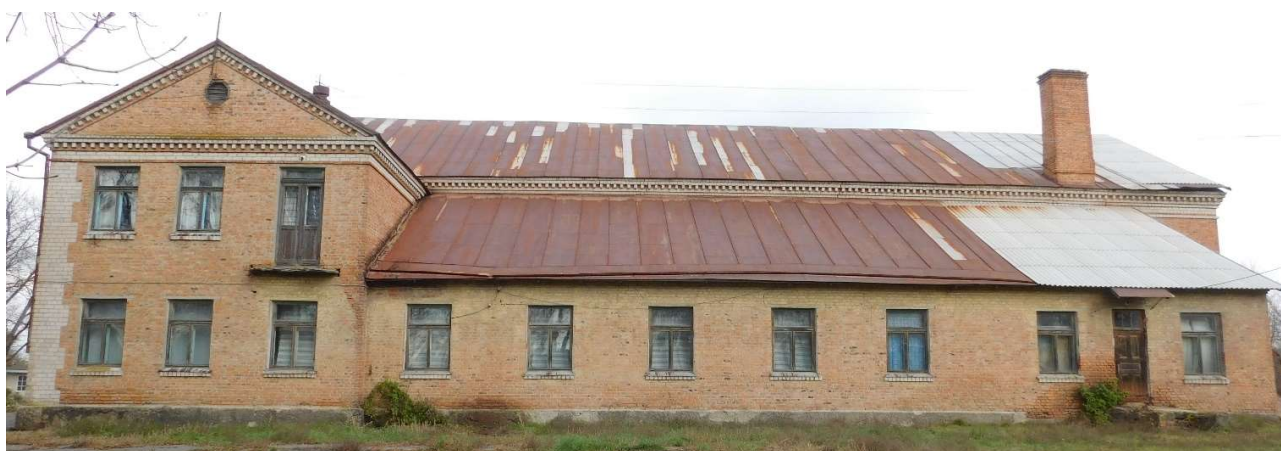
Рисунок 3.2 – Фасад будівлі в осях 9-1
