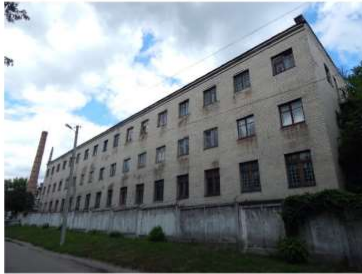
Рисунок 2.2 – Загальний вигляд будівлі по осям Б і І
