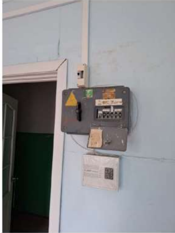
Рисунок 1.14 Стан розподільчих електрощитів
