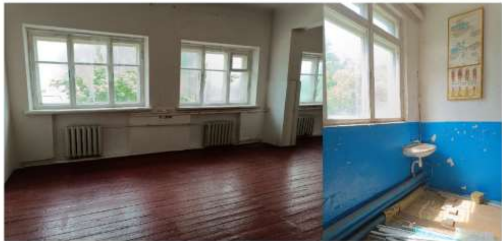
Рис. 1.7. П-подібна однотрубна система, подавальний та зворотній трубопроводи системи опалення
