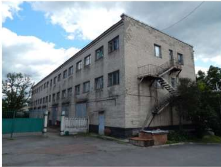
Рисунок 1.1 – Загальний вигляд будівлі по осям А і 10
