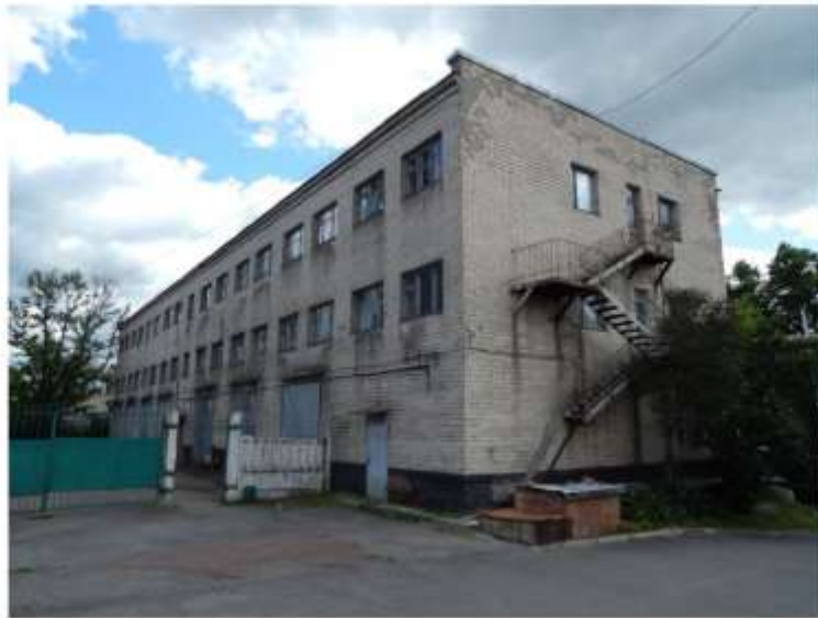
Рисунок 2.1 – Загальний вигляд будівлі по осям А і 10
