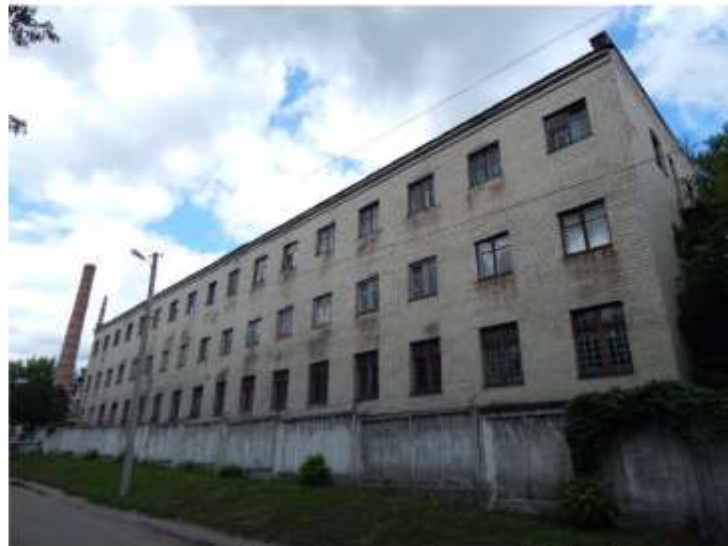
Рисунок 1.2 – Загальний вигляд будівлі по осям Б і 1
