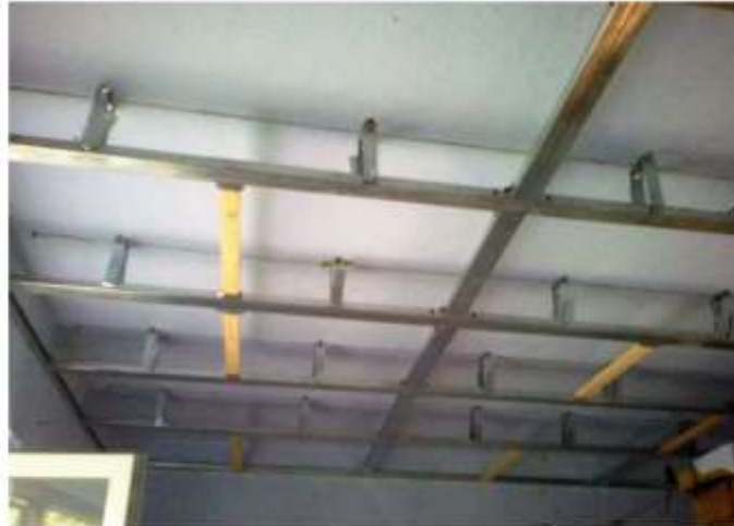
Рис. 7 Встановлення профіля для спирання гіпсокартону
