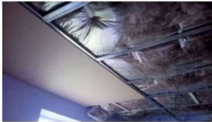
Рис. 10 Кріплення гіпсокартону
