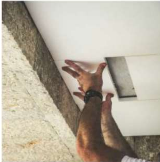
Рис. 2 Утеплення стелі пінополістиролом
