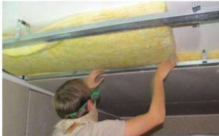
Рис. 5 Вкладання утеплювача
