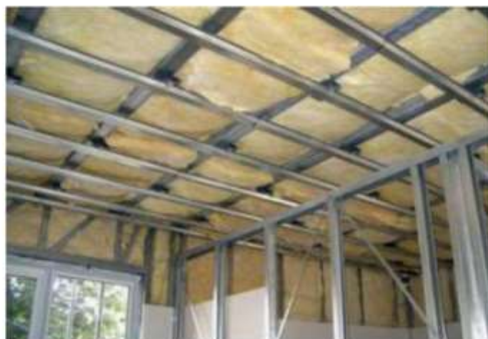
Рис 4 Улаштування металевого каркасу
