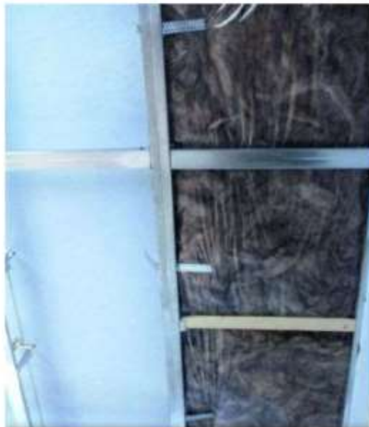
Рис. 8 Встановлення утеплювача на каркас підвісної стелі
