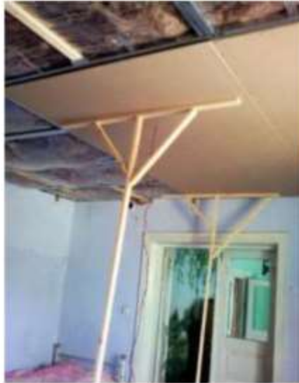
Рис. 9 Гіпсокартон встановлений у проектне положення
