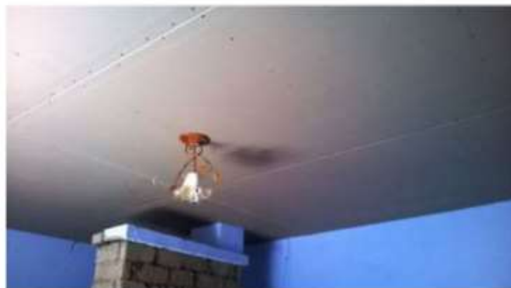
Рис. 11 Готова гіпсокартонна стеля
