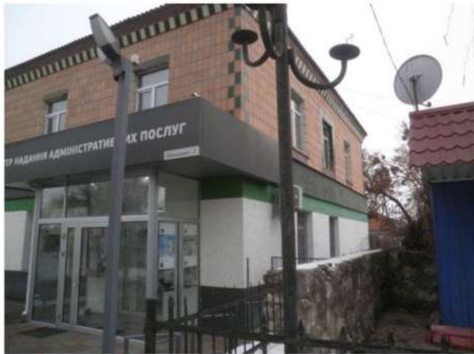
Рисунок 3.3. – Загальний вигляд будинку справа (Фасад А-Г)
