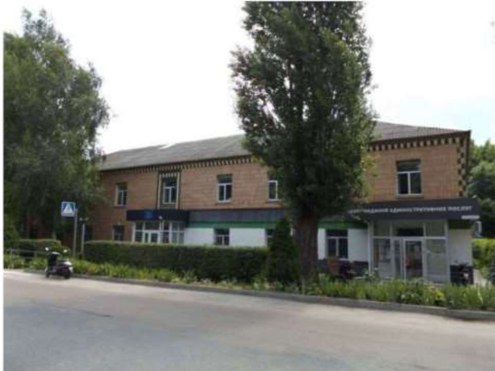
Рисунок 3.1. – Загальний вигляд будинку спереду (Фасад 1-4)
