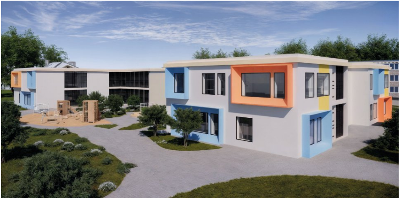
Рисунок 2.10 Перспектива будівлі з внутрішнього двору
