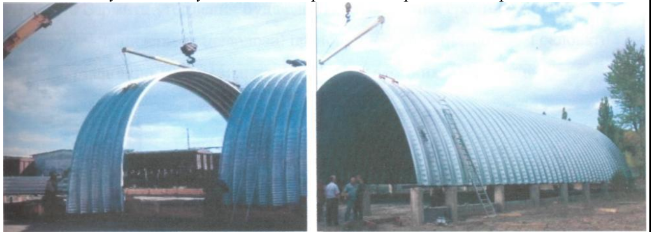
Рис. 1.2. Монтаж безкаркасних арокних конструкцій
