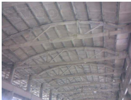
1.3. Промислова будівля із залізобетонним каркасом
