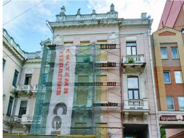
Рис.3.9.– м. Полтава. Демонтовані балкони Палацу дитячої та юнацької творчості
