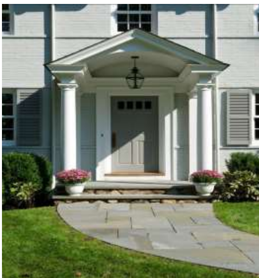
Рис.2.12.– Козирок над входом будинку, 61 Studio Hill Cir, США, штат Коннектикут
