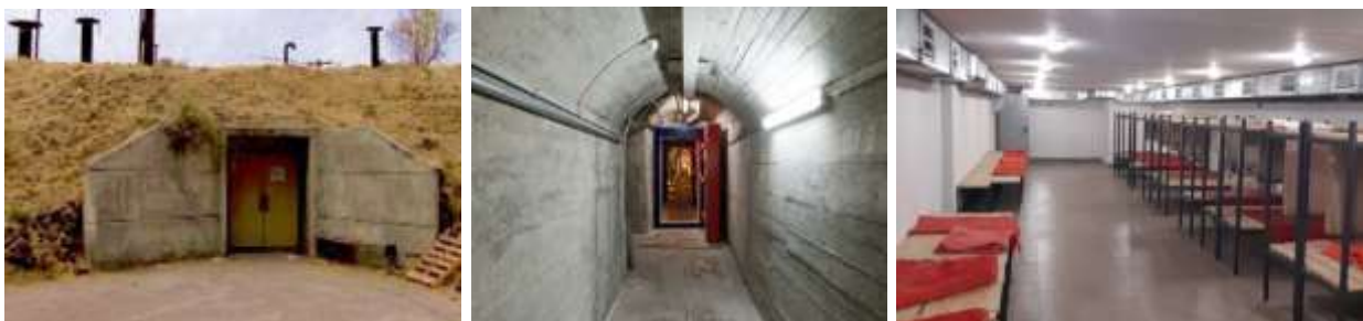
Рис. 1.2. – Захисні споруди цивільного захисту
