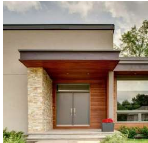
Рис.2.8.– Козирок над входом до котеджу, Канада, Оттава
