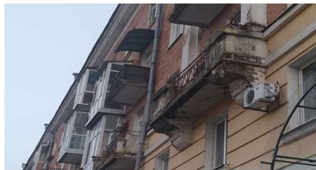
Рис.3.11– м. Львів, вулиця Фурманська. Під номером будинку № 8 над під'їздом «висить» аварійний балкон. Аби він не впав на голову мешканцям будинку та перехожим його підперли дерев'яними дошками.
