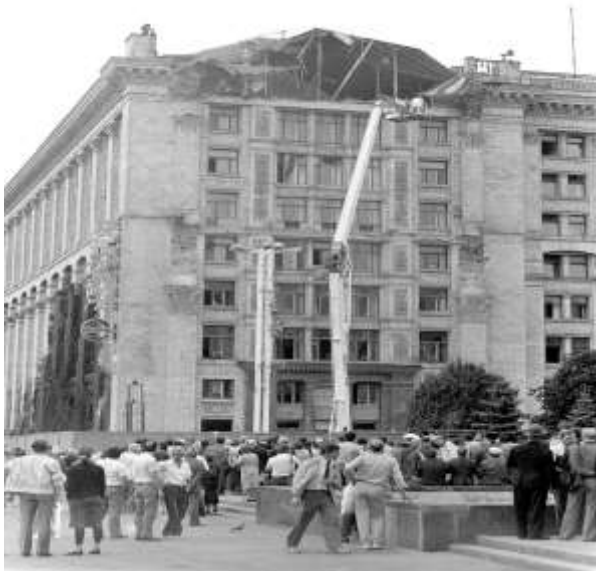
Рис. 3.22. – Центральний вхід до Головного штабу після обвалу колон, м. Київ 2 серпня 1989 року. Відновлені колони порталу у наші дні. Навіть через багато років плитка колон має набагато світліший колір у порівнянні із рештою будівлі
