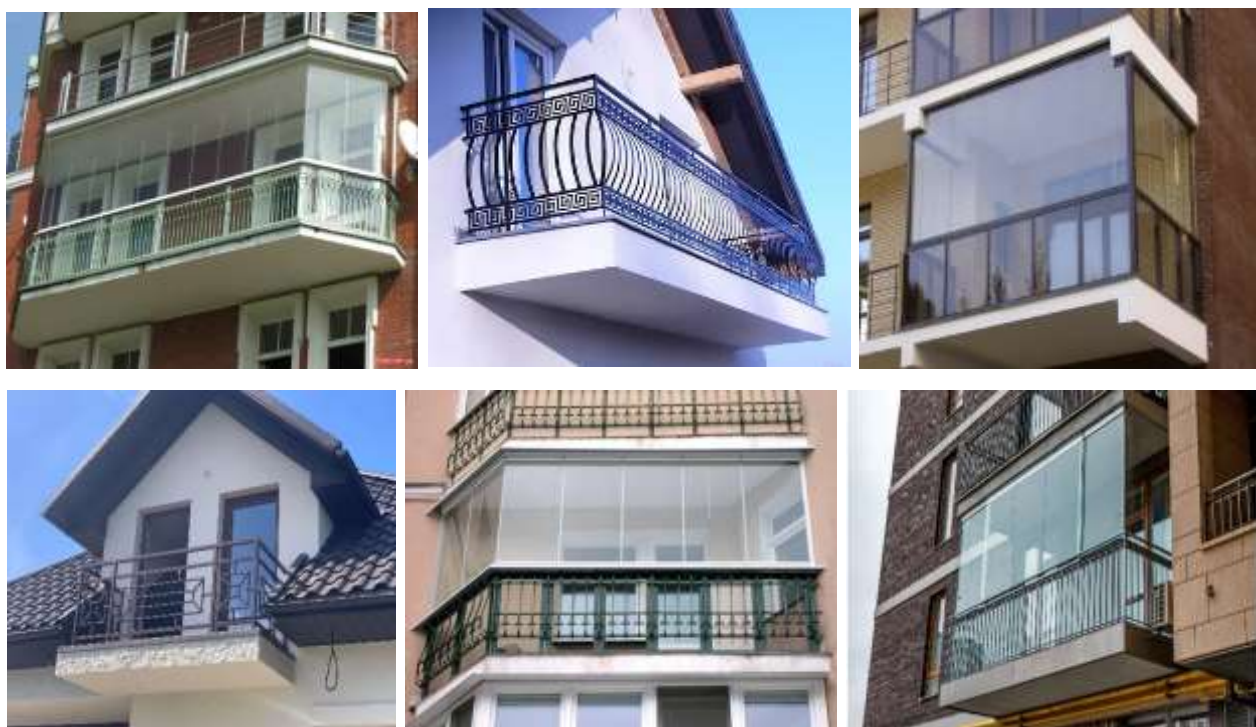
Рис.2.5.– Сучасні залізобетонні консолі балконів
