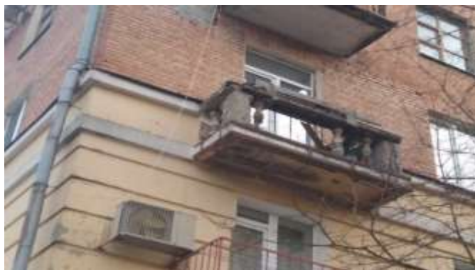
Рис.3.12. – м. Полтава, вулиця Сінна, балкони в аварійному стані
