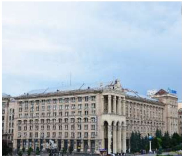
Рис. 3.22. – Центральний вхід до Головного штабу після обвалу колон, м. Київ 2 серпня 1989 року. Відновлені колони порталу у наші дні. Навіть через багато років плитка колон має набагато світліший колір у порівнянні із рештою будівлі
