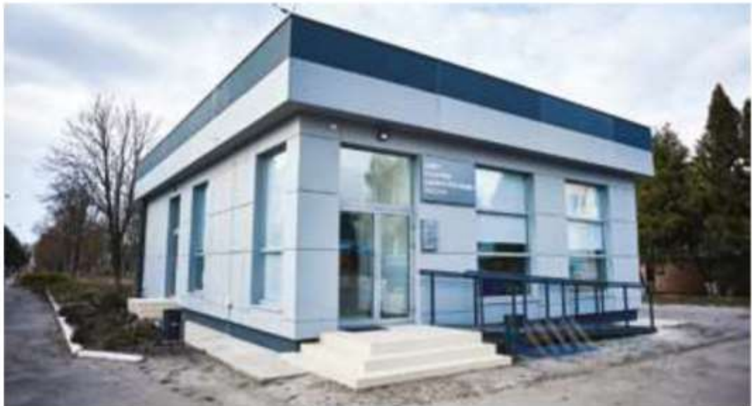
Рисунок 1.6 – Будівля ЦНАП у Миколаївській ТГ з SIP-панелей
