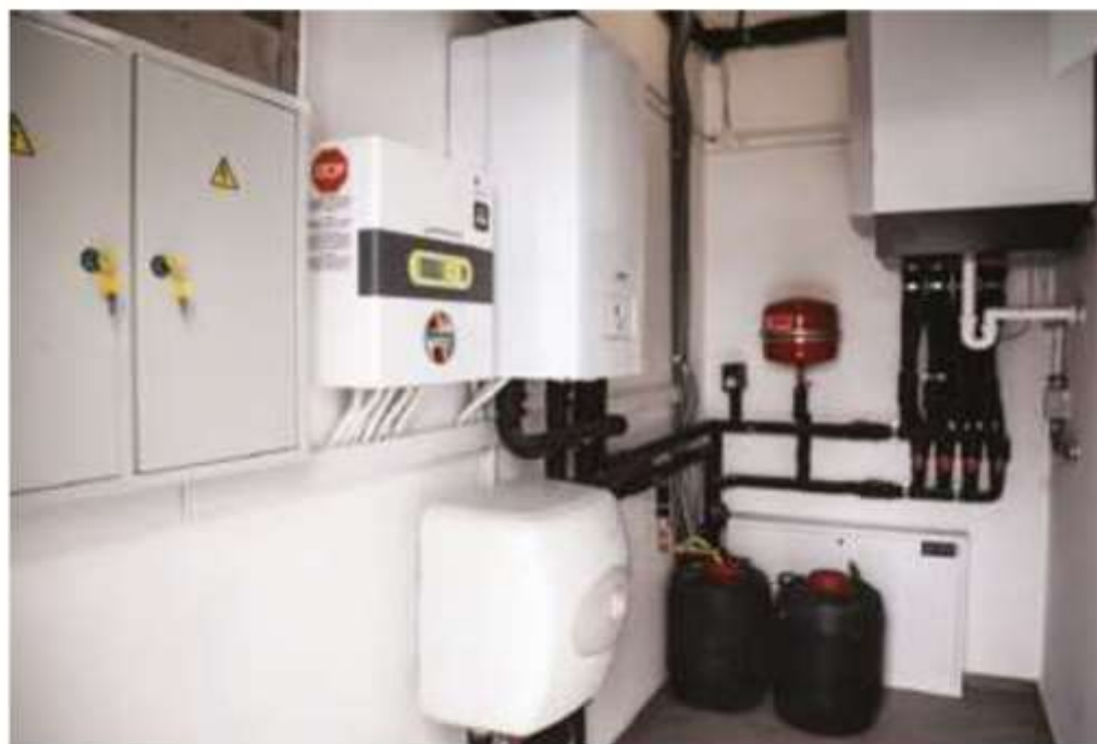
Рисунок 1.2 – Система теплового насосу «повітря/вода»
