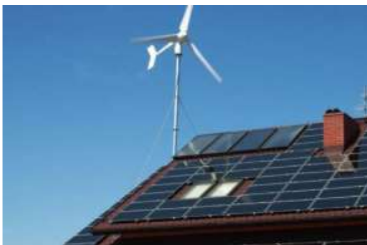
Рис 3.2 – Вітрогенератор на даху будівлі
