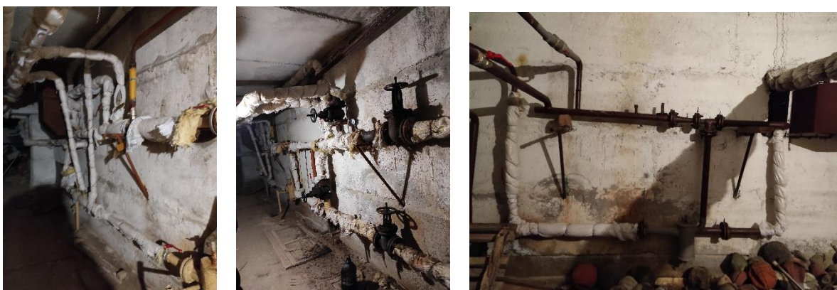
Рис. 2 Індивідуальний тепловий пункт корпусу «Ф» з двома елеваторними вузлами
