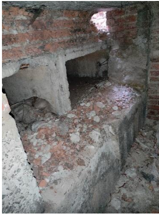
Рис. 3 Стан окремих елементів централізованої припливної системи вентиляції в підвалі корпусу «Ф»
