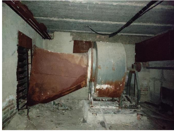
Рис. 3 Стан окремих елементів централізованої припливної системи вентиляції в підвалі корпусу «Ф»
