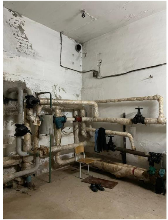
Рис. 2 Індивідуальний тепловий пункт корпусу «А» з двома елеваторними вузлами
