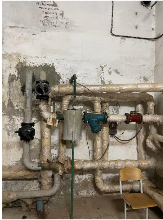
Рис. 2 Індивідуальний тепловий пункт корпусу «А» з двома елеваторними вузлами
