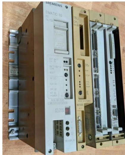
Рисунок 1.3 – Контролер S5-115U фірми Siemens лінії виробництва шоколадної глазури
