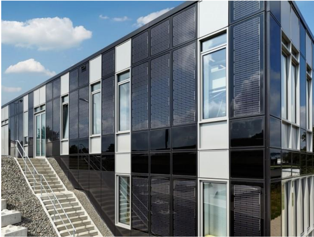
Рисунок 2.6 – Вид інтегрованої панелі в конструкції будівлі.
