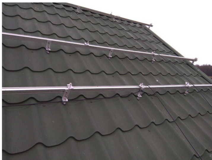
Рисунок 2.11 Система кріплення у зборі без фотомодулів
