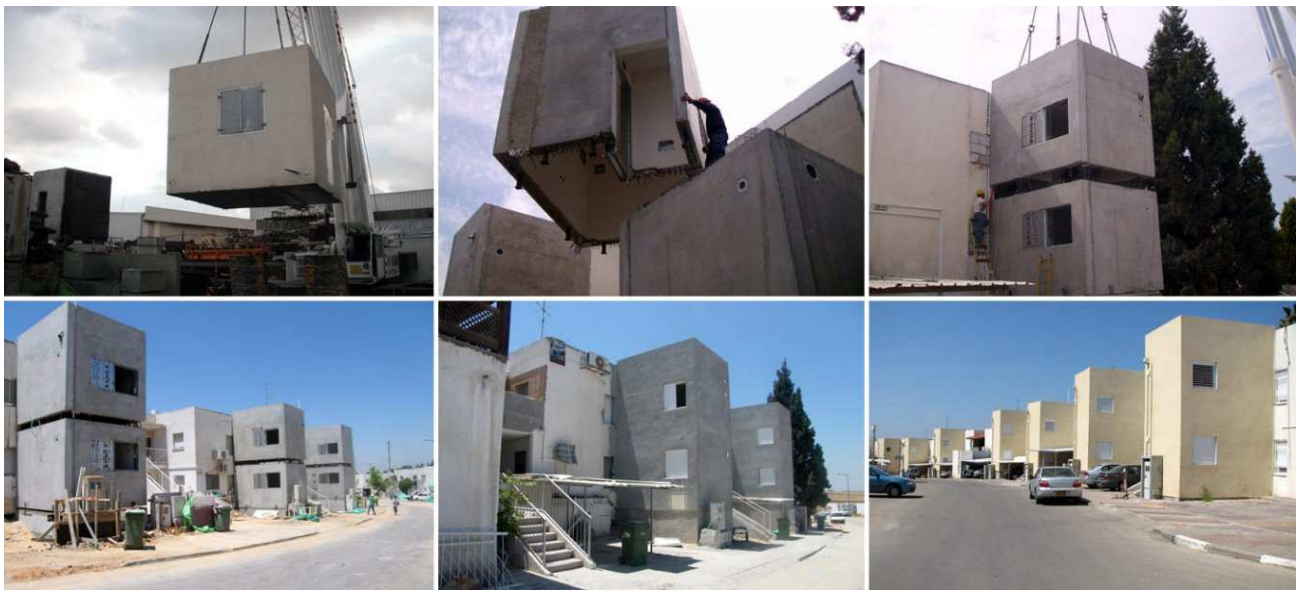
Рис. 2.5, 2.6. Будівництво захищеної кімнати «Мамаду»
