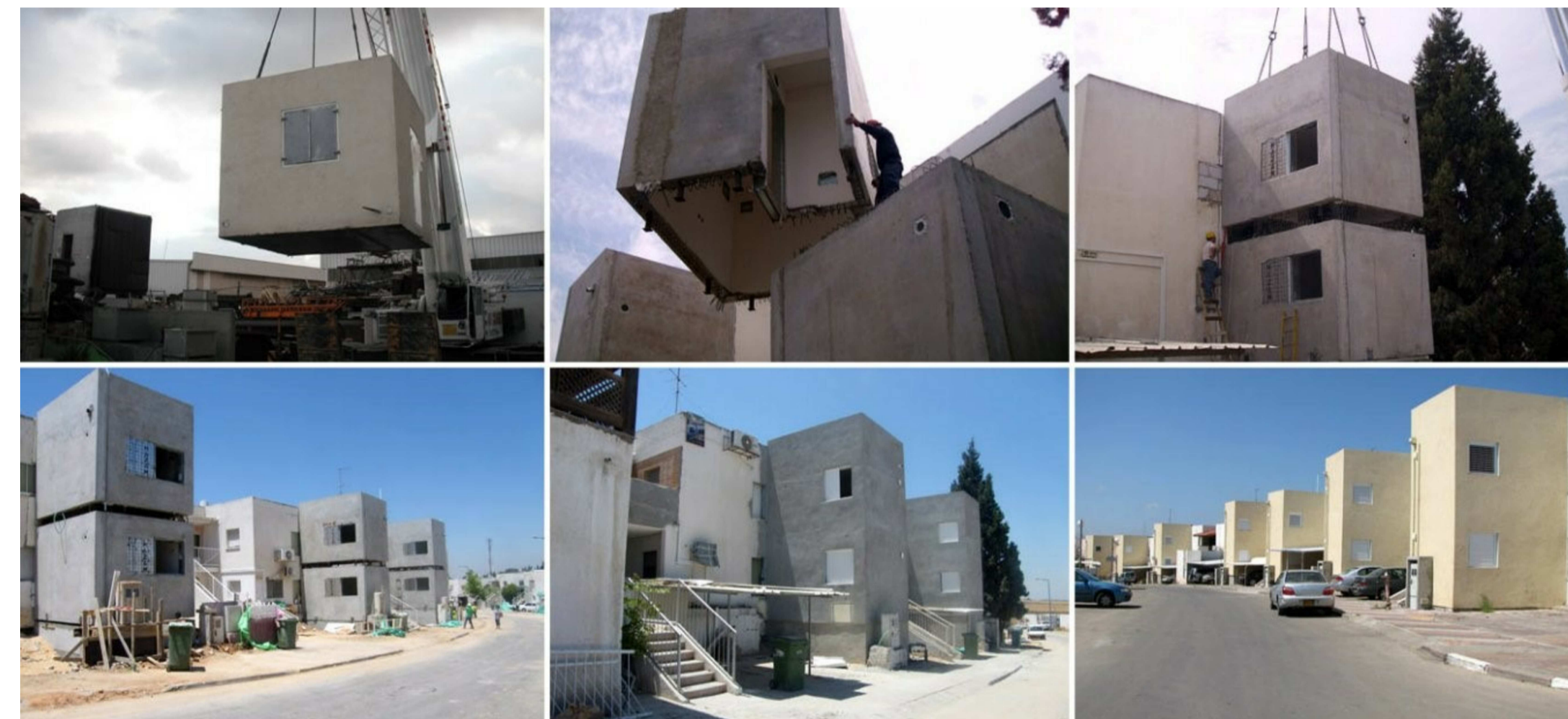
Будівництво захищеної кімнати "мамад"
