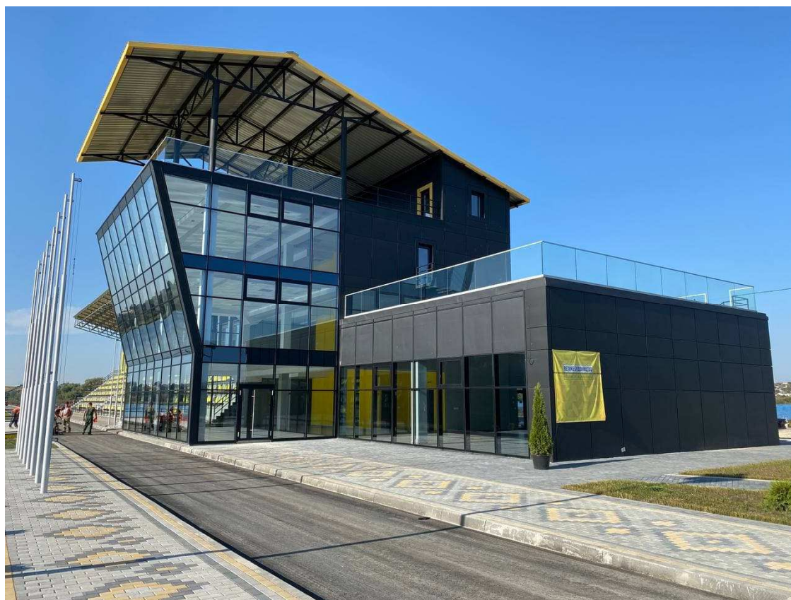
Рис. 2.8. Скляний фасад з триплексу
