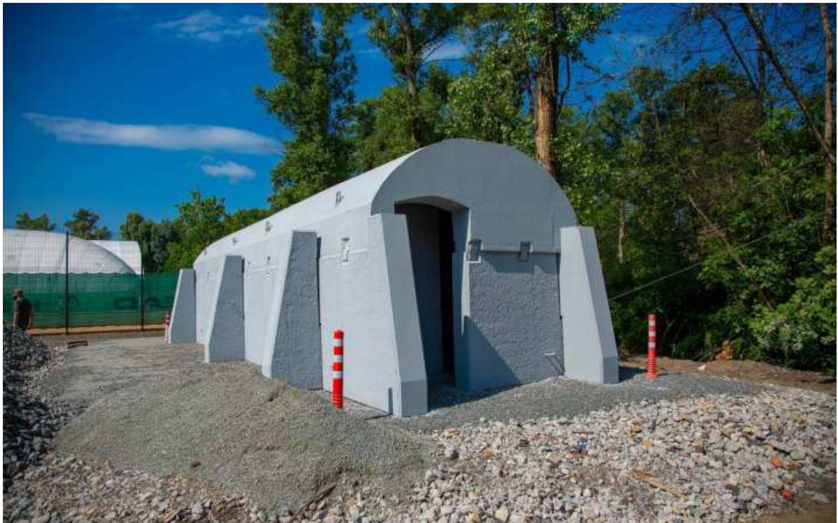
Рис. 1.4. Швидкосторуджувана захисна споруда цивільного захисту
