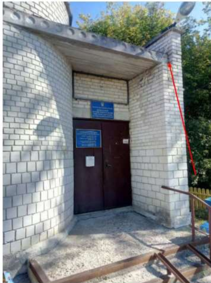
Рисунок 2.12 – Сліди замочування кладки стіни по осі 4 та Г
