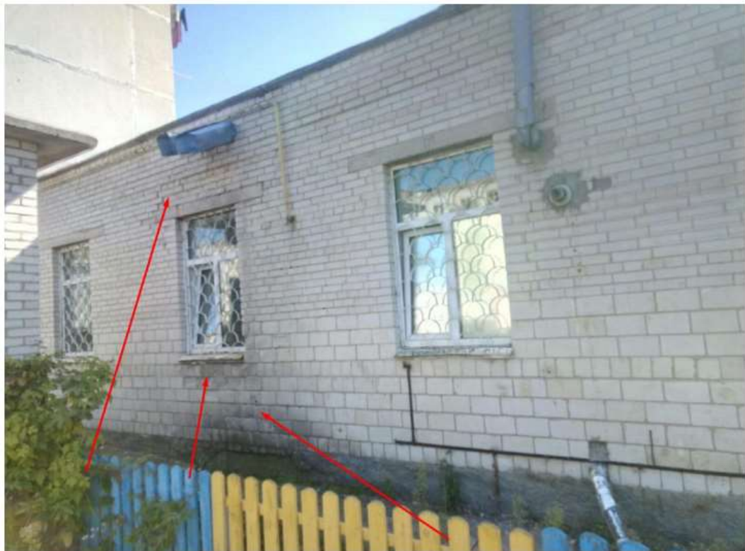
Рисунок 2.8 – Сліди замочування кладки стіни з випадінням розчину із швів по осі А
