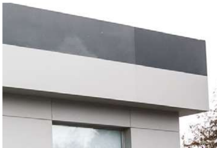
Рисунок 1.48 – Для фасаду ЦНАП в Миколаївській громаді використано фіброцементні плити
