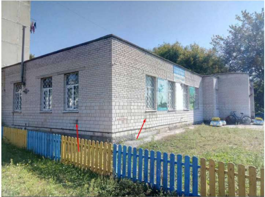
Рисунок 2.9 – Сліди замочування кладки стіни по осі А та 4
