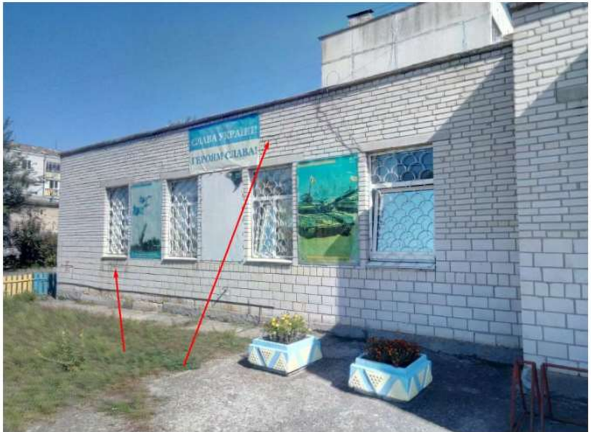
Рисунок 2.10 – Сліди замочування кладки стіни з випадінням розчину із швів по осі 4
