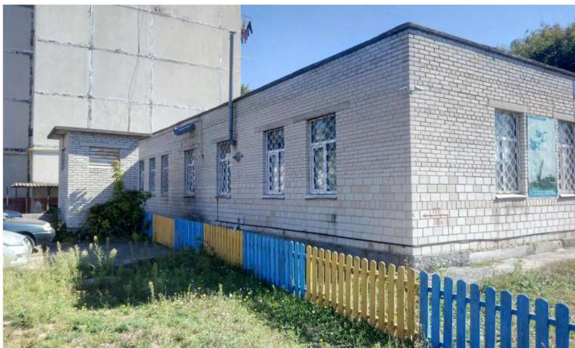
Рисунок 3.7 – Існуючий стан будівлі
