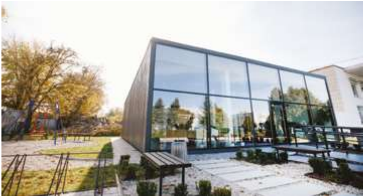
Рисунок 1.5 – Будівля ЦНАП у Полонській ТГ з SIP-панелей
