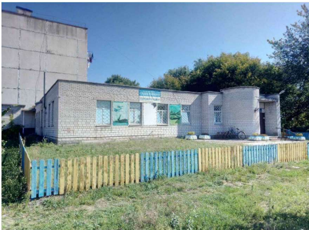
Рисунок 2.1 – Загальний вигляд громадської будівлі
