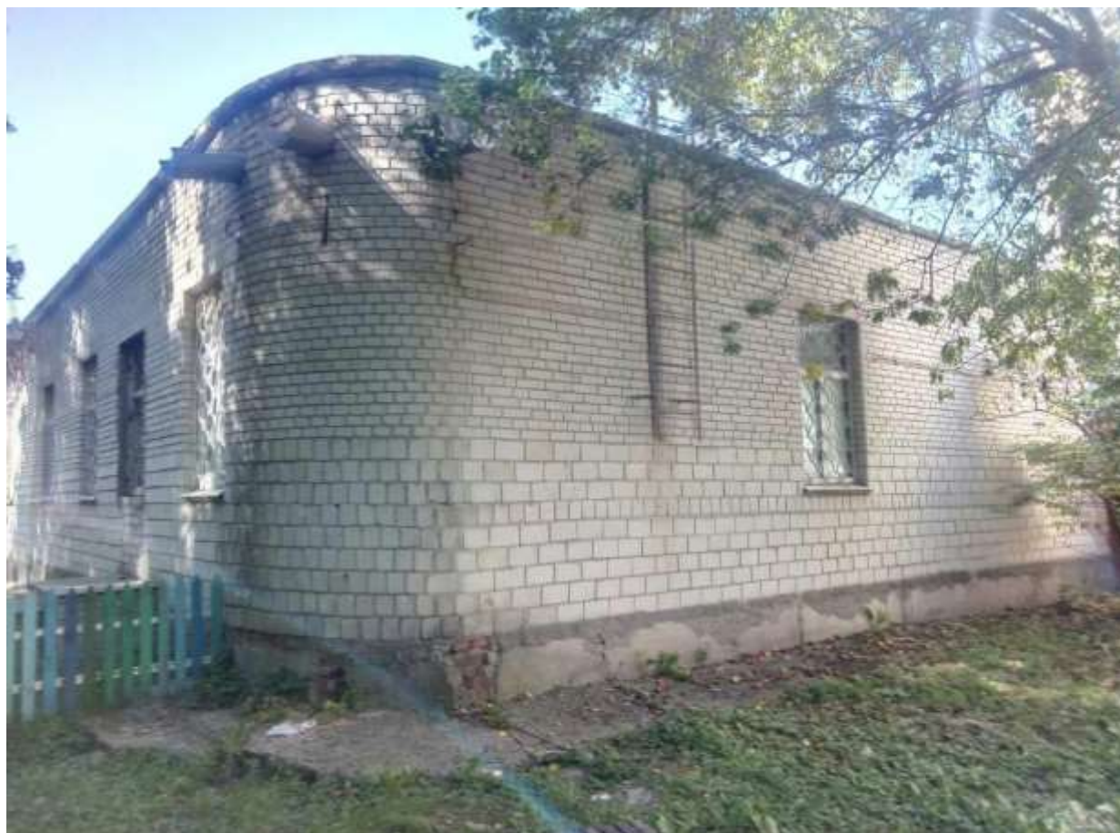
Рисунок 2.3 – Загальний вигляд громадської будівлі
