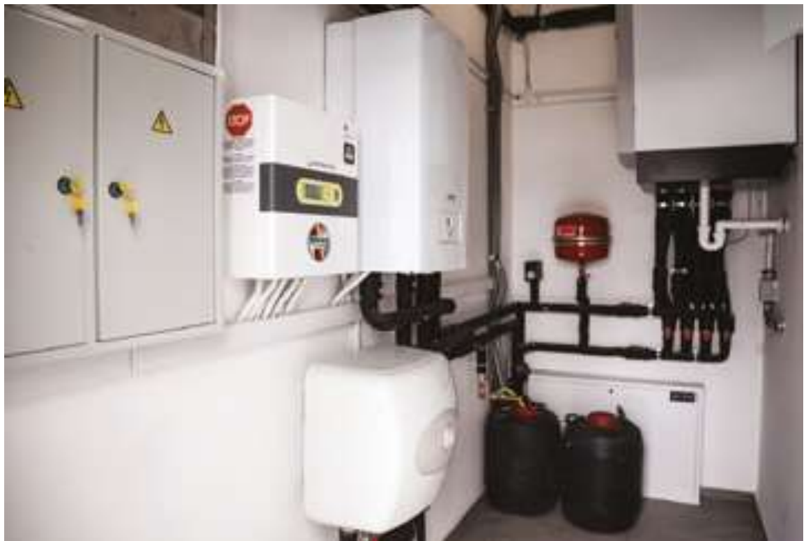
Рисунок 1.2 – Система теплового насосу «повітря/вода»
