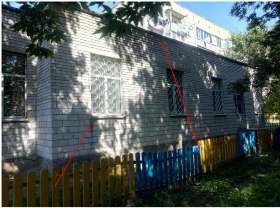
Рисунок 2.11 – Сліди замочування кладки стіни з випадінням розчину із швів по осі Г
