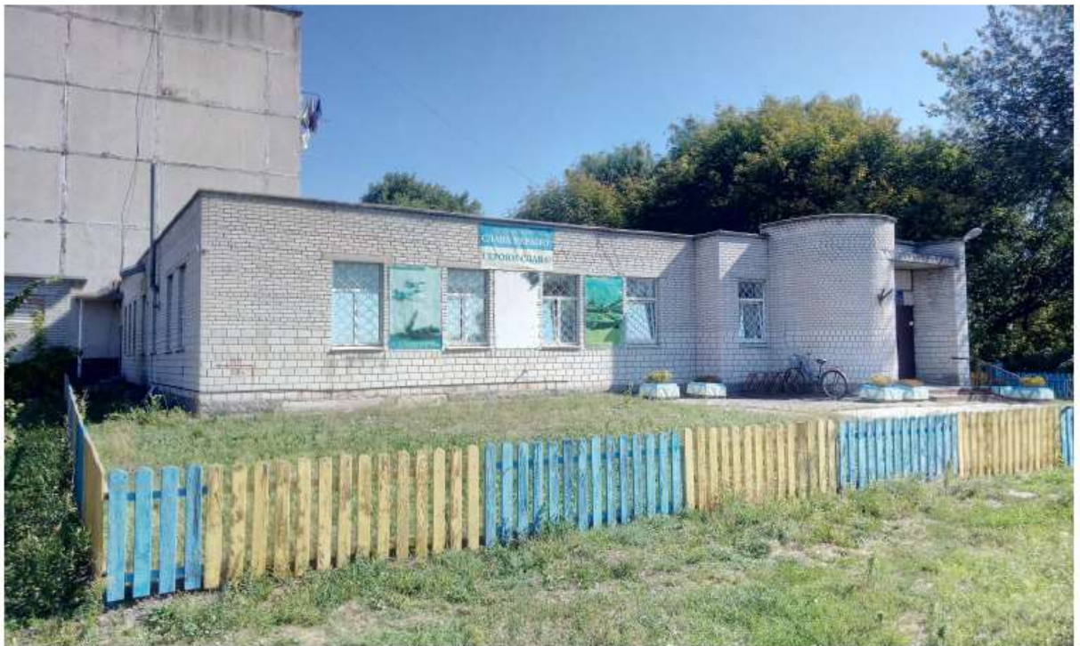
Рисунок 3.6 – Існуючий стан будівлі
