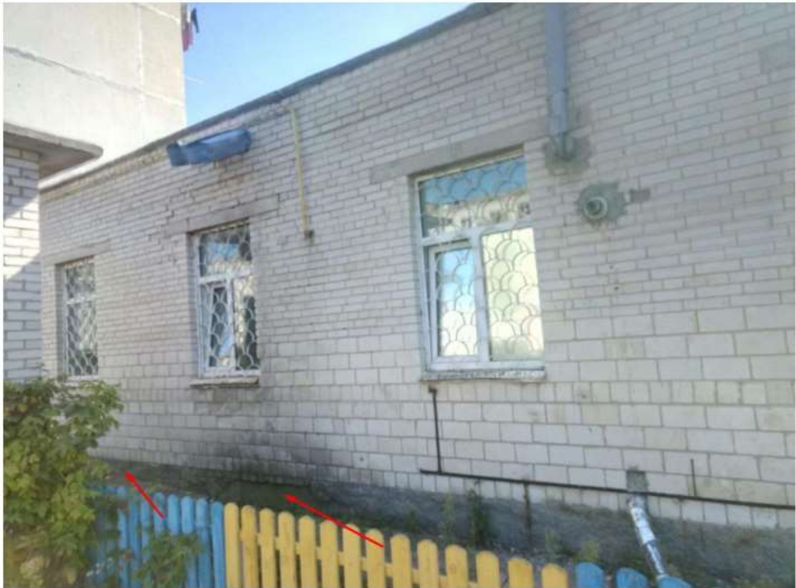
Рисунок 2.4 – Відокремлення захисного шару цоколю по осі А
