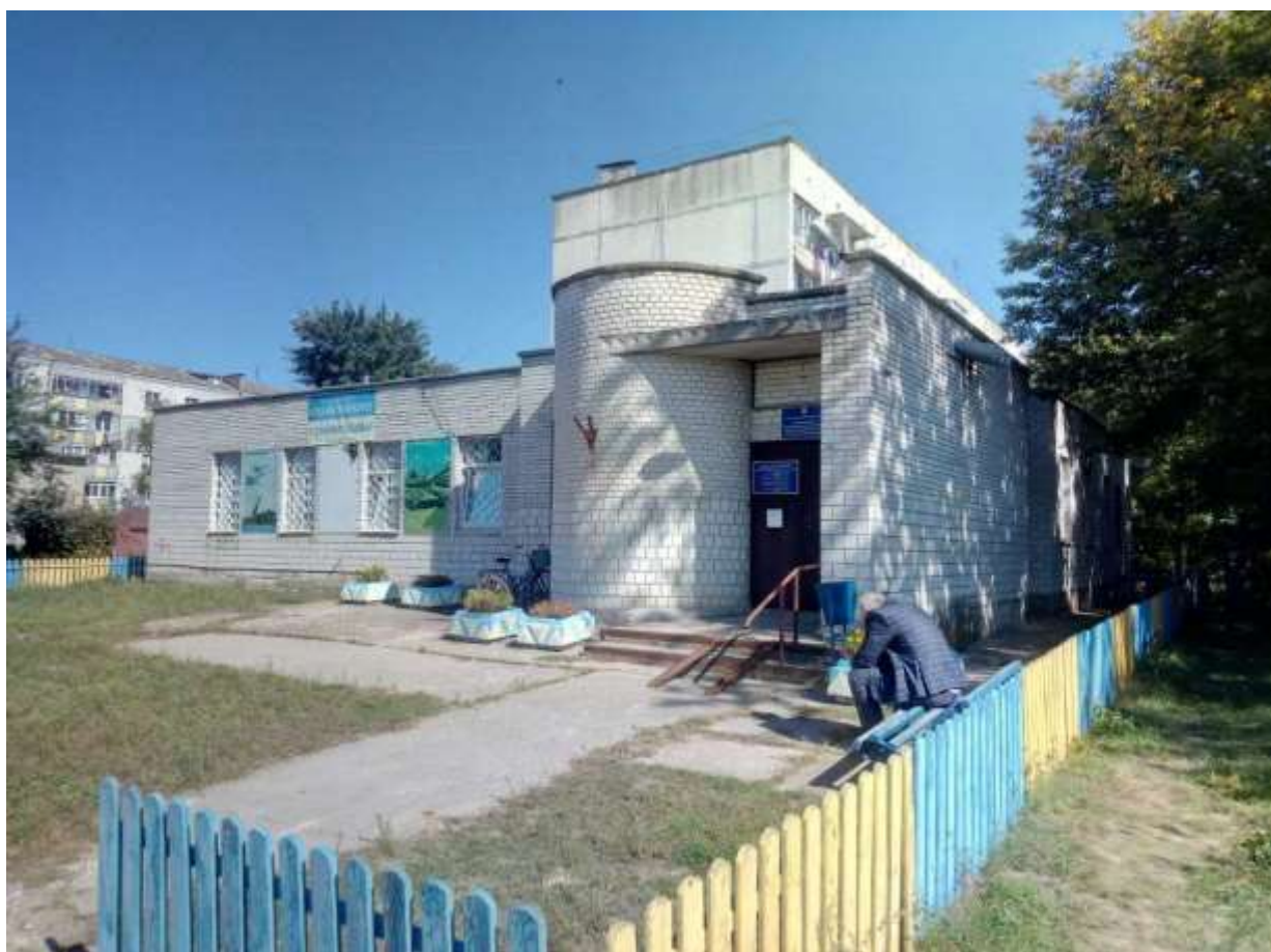
Рисунок 2.2 – Загальний вигляд громадської будівлі
