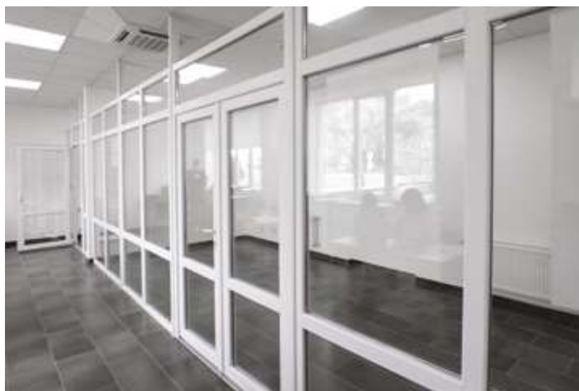
Рисунок 1.42 – Виконання металопластикової перегородки у ЦНАП в Вишнівській ТГ
