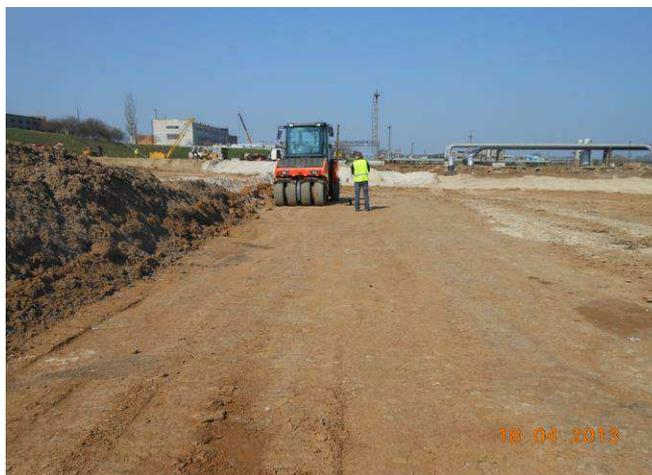
Рис. 1. Ущільнення шару ґрунту дорожнього насипу котком НАММ HD150
