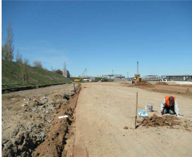
*Рис. 2. Зняття верхньої частини ґрунтового шару для відбору зразків ґрунту*
