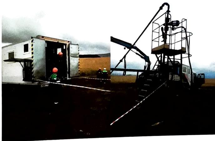
Рис. 4.2. Підготовчі роботи на свердловині № 61 перед проведенням гідроімпульсного впливу на ПЗП
