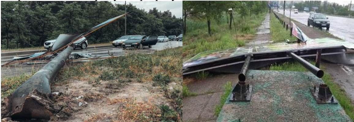
Рис. 3. Рекламні конструкції що не витримали навантаження.
