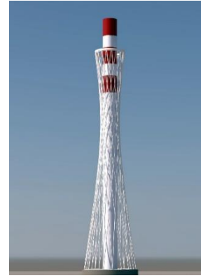
в. Фахверкова оболонка підтримуюча трубу
