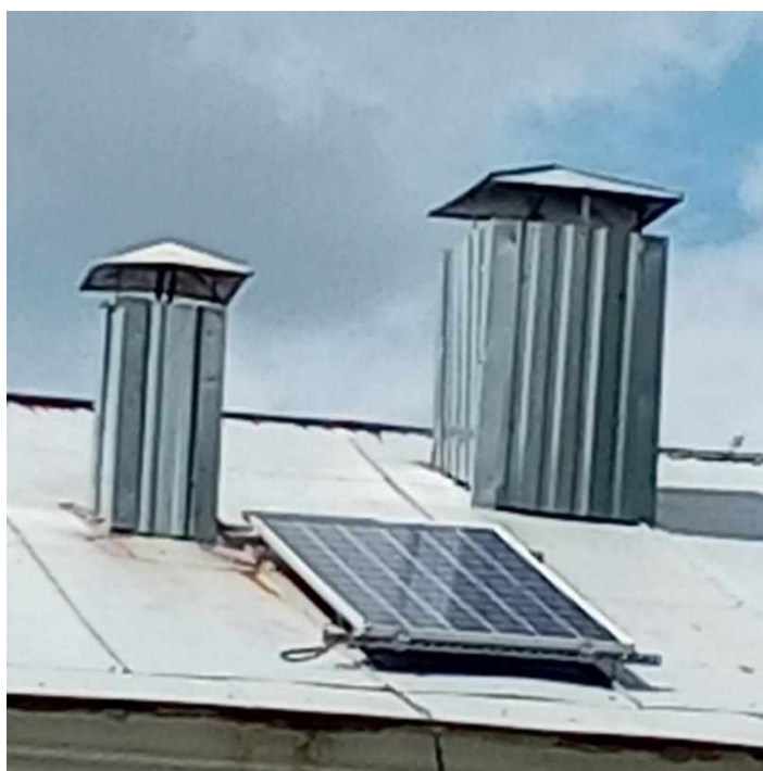
Рис. 1. Розташування фотоелектричної панелі AS-6P-340W на даху
