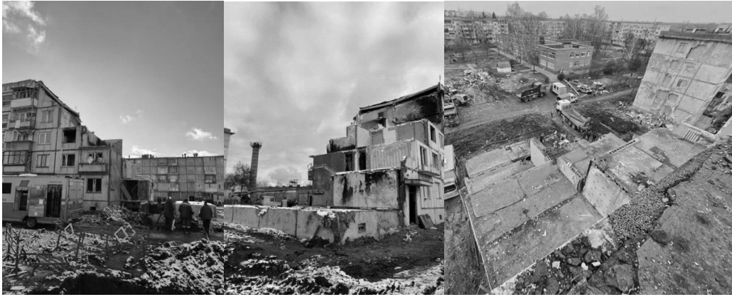
Рис. 2. Уражений ракетою будинок по вул. Баленка, 7
