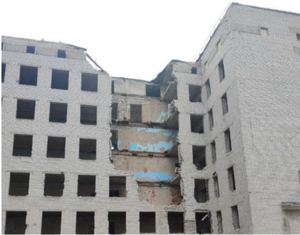
Рис. 1 Пошкодження цегляної кладки внаслідок військової агресії
