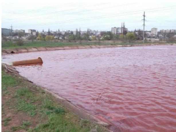
Рис. 6 Ставок освітлювач шахтної води з шахти “Родіна” у місті Кривий Ріг.
