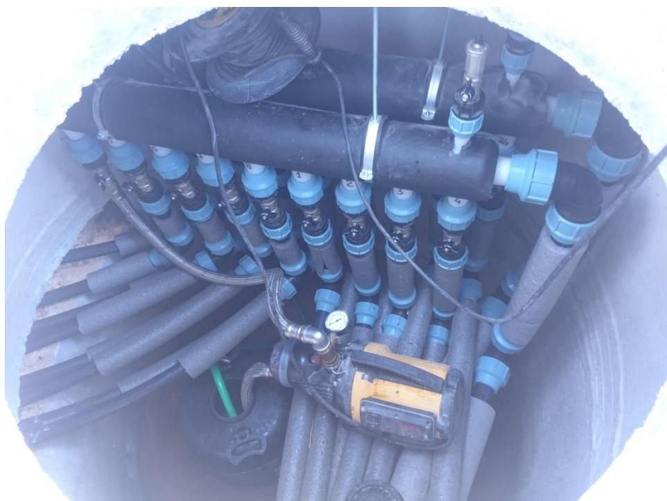
Рисунок 3.15 – Процес прокачки геоконтура теплового насоса ґрунт-вода.
