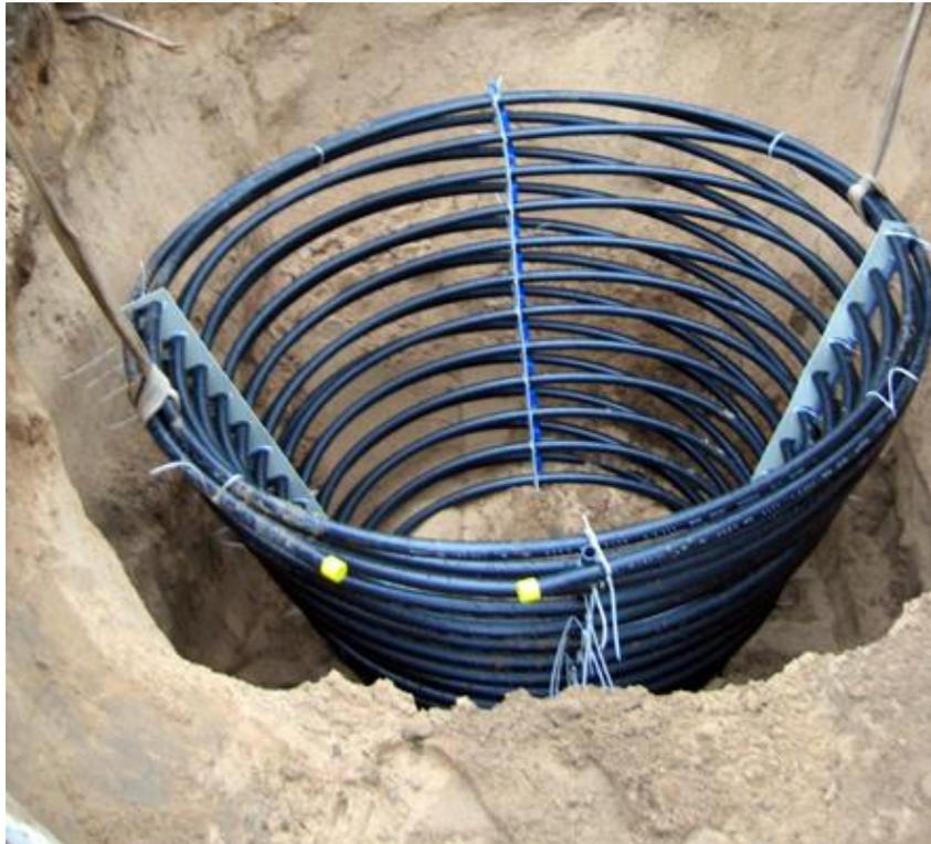
Рисунок 3.12 – Спіральний колектор
