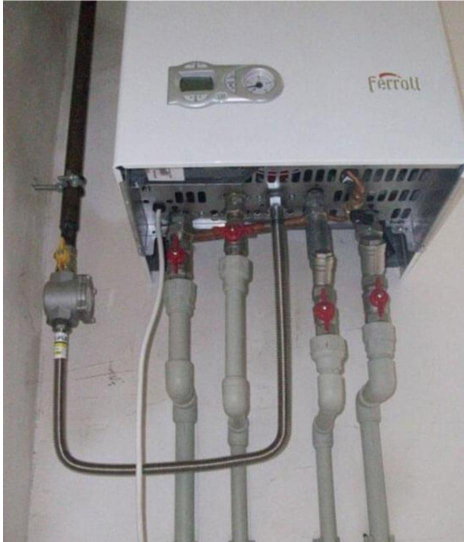
Рисунок 2.7 – Фото котла та розподільних трубопроводів
