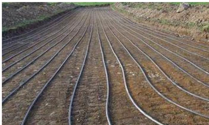
Рисунок 3.9 – Горизонтальний геоконтур
