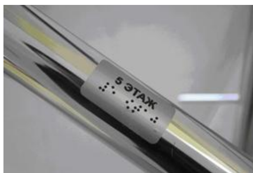
Рис. 4.2. Навігаційні тактильні наліпки на перилах для позначки, виконані в контрастному співвідношенні кольорів і дубльовані шрифтом Брайля [56, 58]
