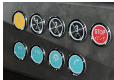
Рис. 4.13. Коліркове кодування інформаційних показників та вимикача світла, що контрастують із поверхнею стіни і забезпечують кращу видимість [54, 56]
