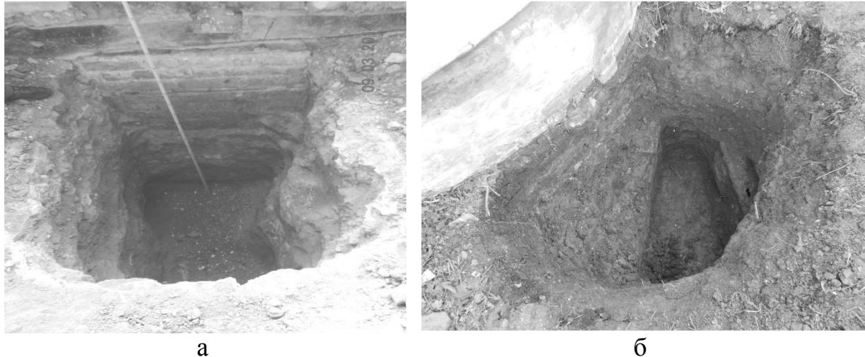
Рис. 2. Вигляд фундаментів у шурфах: а – під зовнішню стіну головного фасаду; б – під зовнішню торцеву стіну в місці її заокруглення
