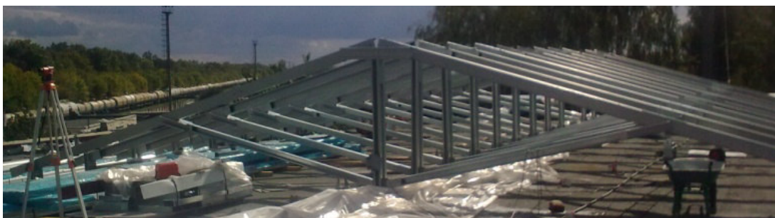
Рис. 2 – Загальний вигляд експериментального зразка кроквяної рами покриття
