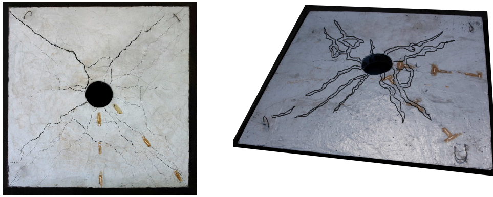
Рисунок 7 -. Характер утворення тріщин на бетонних поверхнях плит
