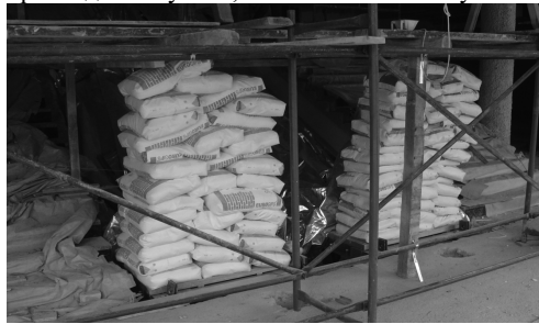
Рис.2. Загальний вигляд випробування сталезалізобетонного ригеля
