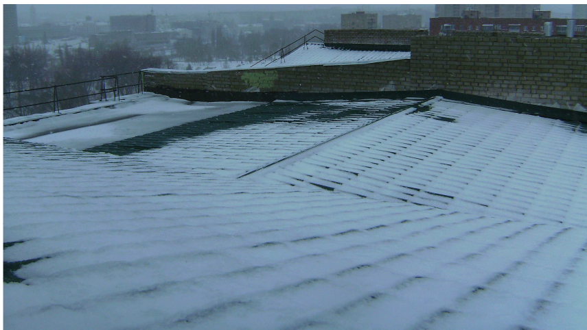
Рисунок 2 – Загальний вигляд даху будівлі
