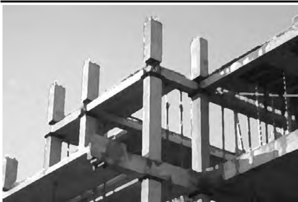
Рис. 1. Каркас САРЕТ у процесі зведення
