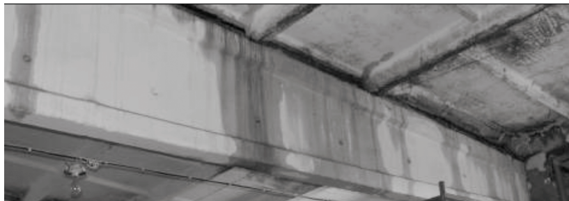
Рис.1. Сліди замочування двосхилої балки покриття
