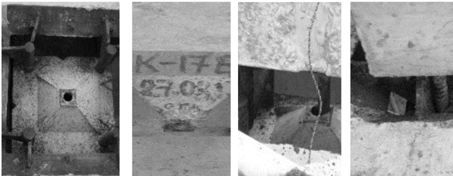
Рис. 4 Етапи влаштування стику надколонної плити з колоною
