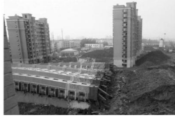
Фото 2. Руйнування недобудованої тринадцятиповерхової споруди, м.Шанхай, Китай
