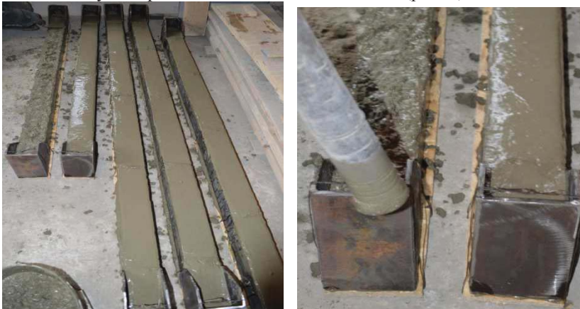
Рис. 2. Бетонування сталезалізобетонних стрижневих конструкцій з використанням листової арматури
