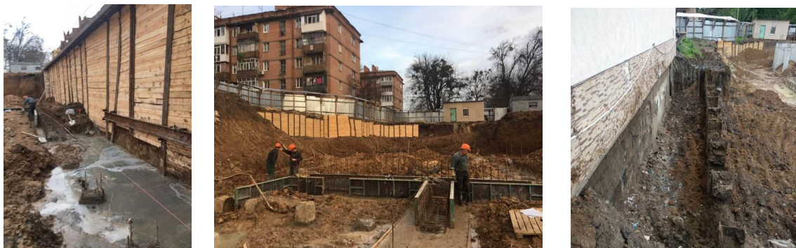
Рисунок 4 – Улаштування котловану та елементів його огородження
